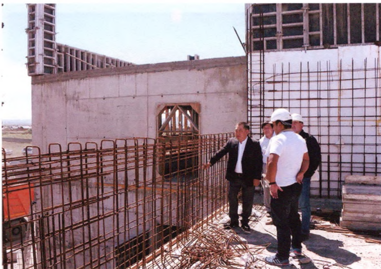
Строительство детского сада на левобережных дачах.
