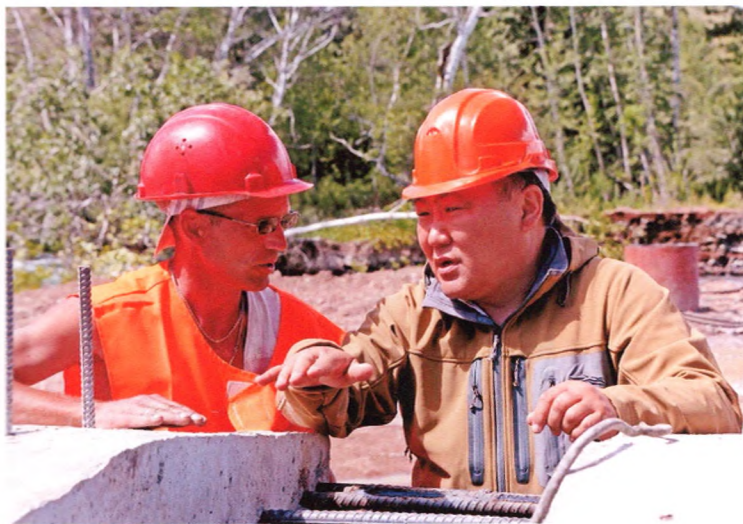
На строительстве моста через р. Хемчик в Бай-Тайге.
