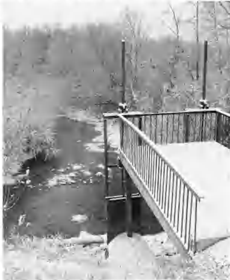
Один из двух рабочих шлюзов в районе Кожзавода
