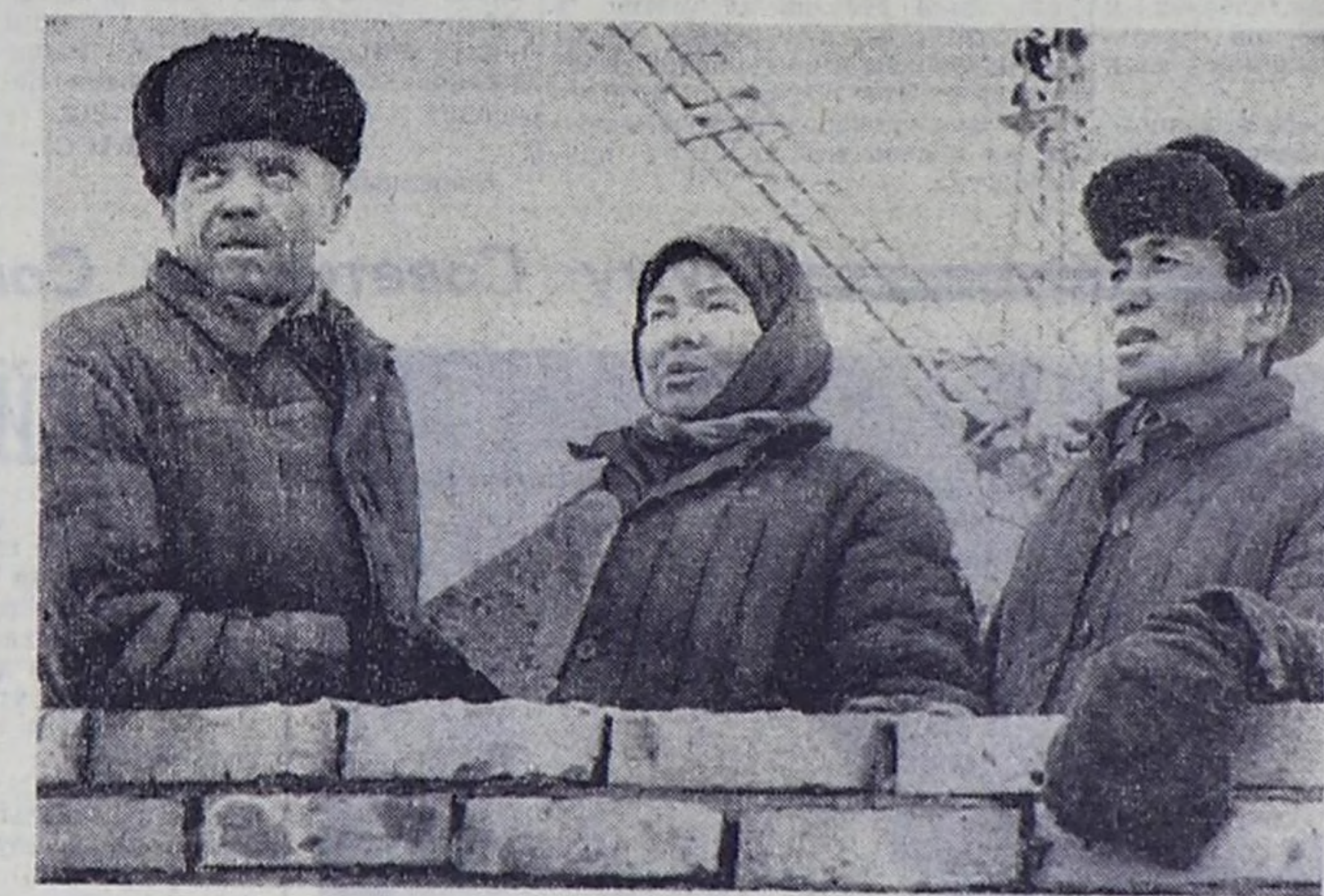
Об Иване Синякове, Марии Васильеве и Буяне Салчаке в большой и дружной бригаде М. Шиповаленко отзываются, как о лучших строителях. 54-квартирный жилой дом, который бригада возводит около первой поликлиники в Каа-Хемском районе, отличается сложностью железобетонных работ. Большой практический опыт, накопленный строителями, помогает им в труде.
