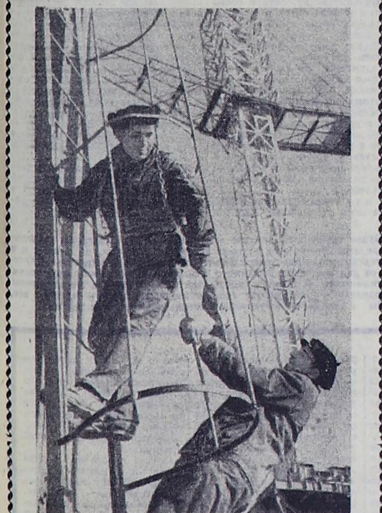
В Киеве ведется строительство нового телецентра. На 372 метра поднимается всяя ажурная башня, с помощью которой будет осуществляться телевизионное вещание по трем программам на расстоянии свыше 100 километров и транспарантное радиовещание. На снимке: монтажники строительного управления №21 строят «Центростальконструкцию» П. В. Родимко (сверху) и Л. Н. Фило на монтаже конструкций телебашни, П. А. Поддубного. (Фотохроника ТАСС).
