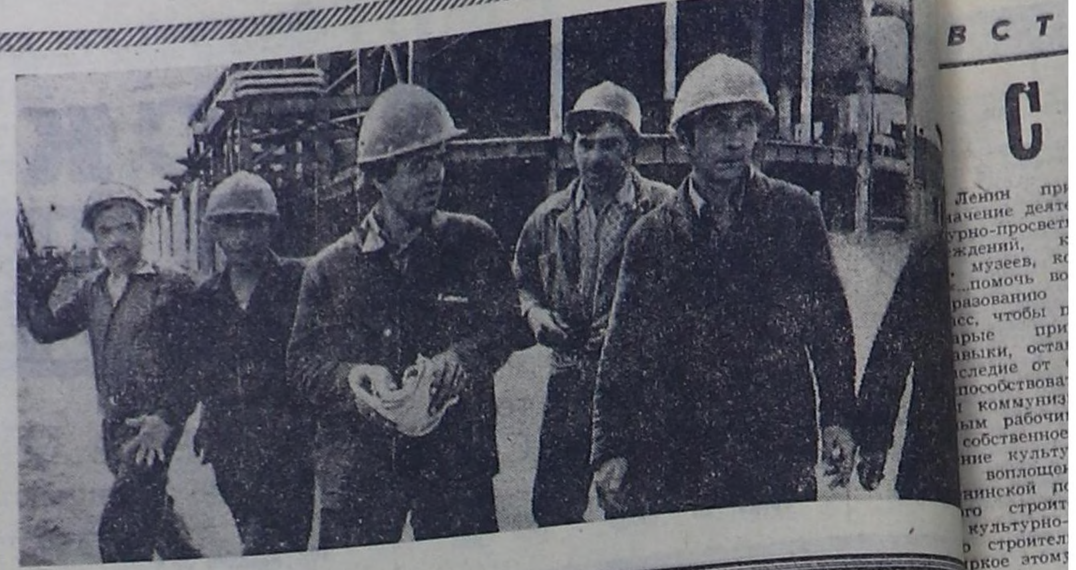
Ф. Гарипов, Л. Котышев, бригадир В. Ефимов, А. Проворотов, А. Крылатов и Л. Волжанкин (на снимке слева направо) — монтажники ПМК-20 треста «Шагонарстрой» — возводят объекты в промышленной зоне Нового Шагонара. Сегодня они ведут монтаж гаража Новошагонарской автобазы треста «Красноярскстройтранс», на котором намечено смену исполнителей задания на 130-135 процентов.
