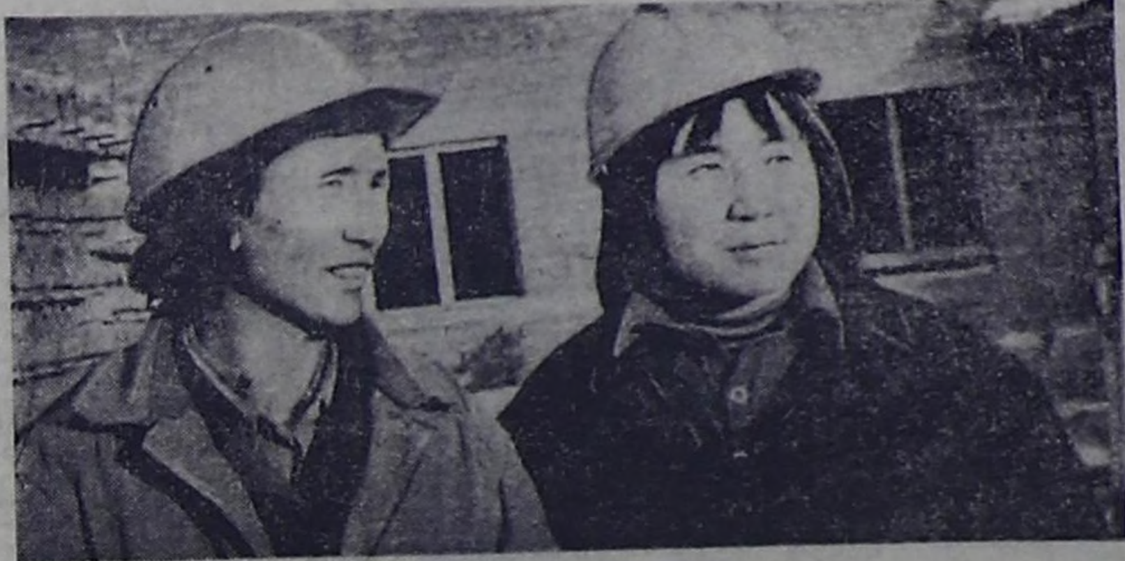
По-ударному трудятся комбинатская строительная бригада К. Кукурузы из строительного управления «Кымыл-промстрой». Работая на объекте для учащихся Кымылского автодорожного техникума, бригада выполняла план октября на 122 процента, значительно приблизив срок сдачи объекта в эксплуатацию.
