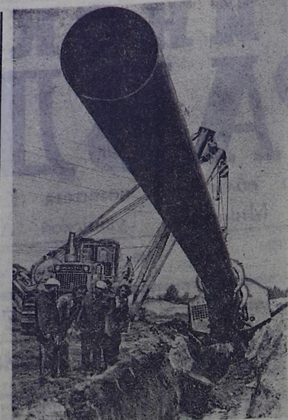
В Челябинской области завершается сооружение газопровода Долгодеревенское — Красногорский, отводной линии магистрального газопровода Вынгаур — Челябинск. Строительство ведут механизированные колонны треста «Уралнефтегазстрой». Скоро газ придет на предприятия Южного Урала.
