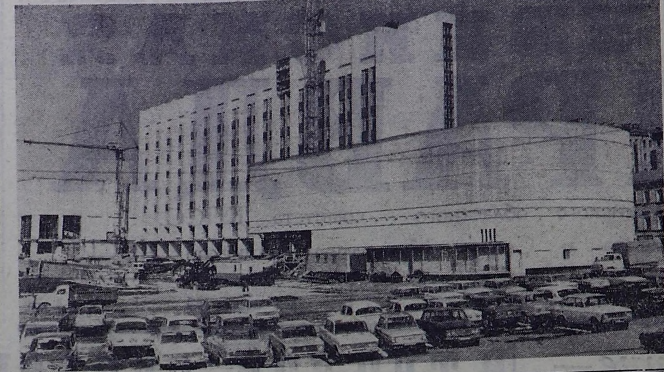
В Москве на Цветном бульваре сооружается комплекс зданий Дома политического просвещения МК и МКГ КПСС (на снимке). Фото В. Егорова и А. Стужина. (Фотохроника ТАСС).
