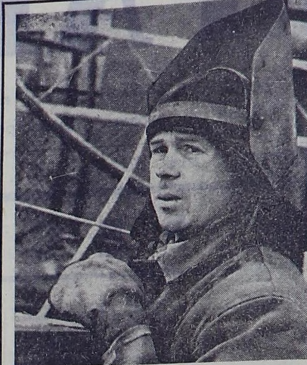
Комсомольско-молодежная бригада УОС-1, которую возглавляет Ю. Ванчагов, выполнила план юбилейного года, уложив 85 тысяч кубометров бетона в плотину Саяно-Шушенской ГЭС.
