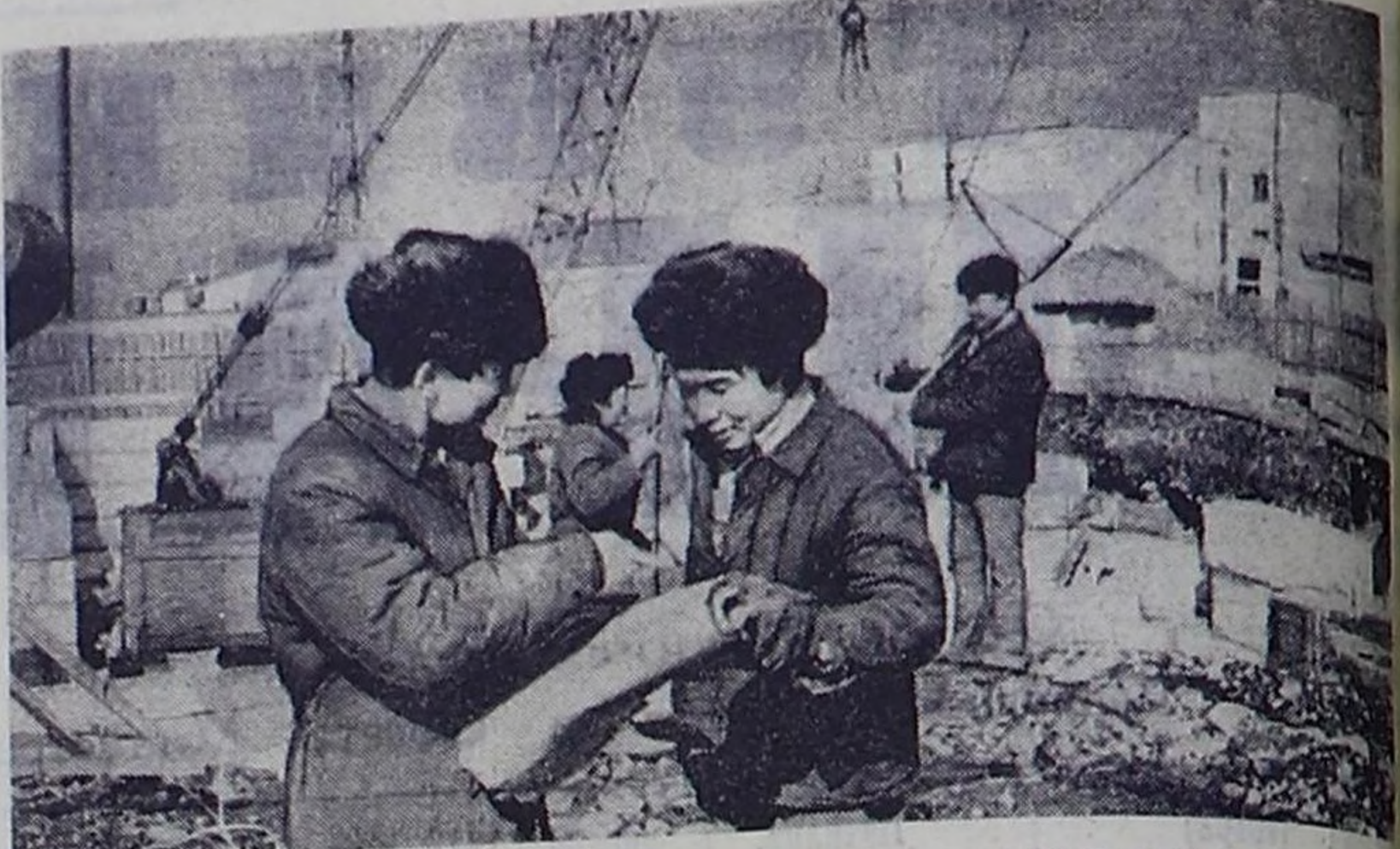
Строится в Кызыле автовокзал
