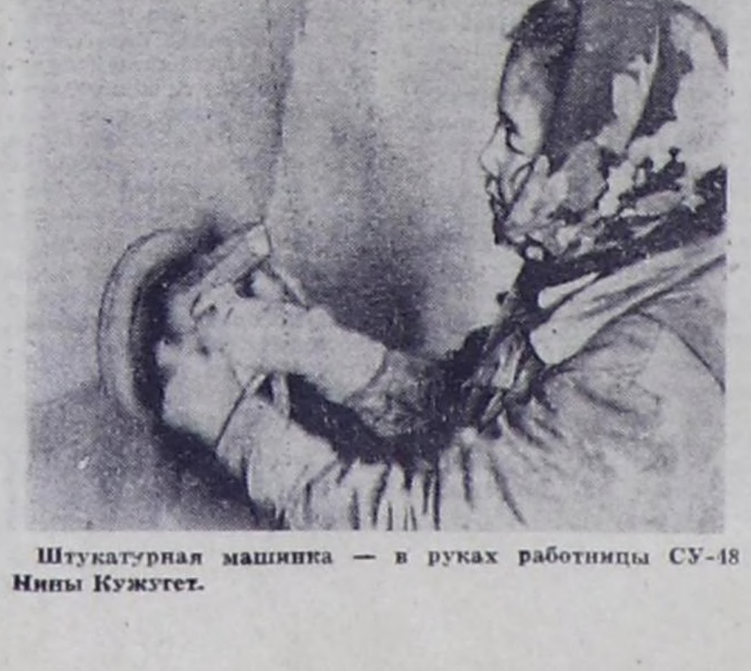
Штукатурная машинка — в руках работницы СУ-48 Нины Кужутет.
