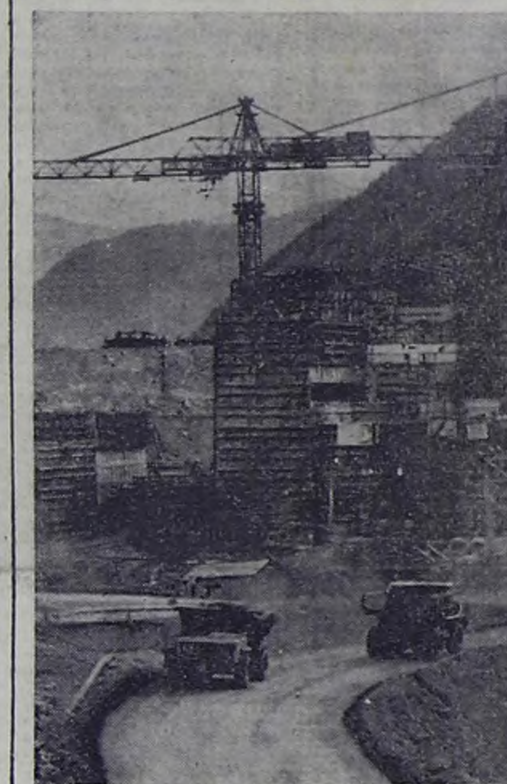
Саяно-Шушенская ГЭС станет энергетическим ядром создающегося в Красноярском крае Саянского территориального комплекса, в состав которого войдут свыше ста крупных производств. Стройка в Саянах вступила в предпоследний период. Строители успешно применяют самую современную высокопроизводительную технику, используют принципиально новые методы строительства. Это результат тесного производственного, научно-технического сотрудничества, социалистического соревнования трудовых коллективов предприятий и организаций, участвующих в создании уникального гидроузла. В год 60-летия Великой Октябрьской революции строители решили уложить в тело плотин миллион кубометров бетона. Такие скорости темпы возведения плотин в отечественном гидростроении будут достигнуты впервые. Первый агрегат Саяно-Шушенской ГЭС даст ток в 1978 году. На снимке: день ото дня растут бетонные блоки плотин. Фото Р. Денисова. (Фотохроника ТАСС).
