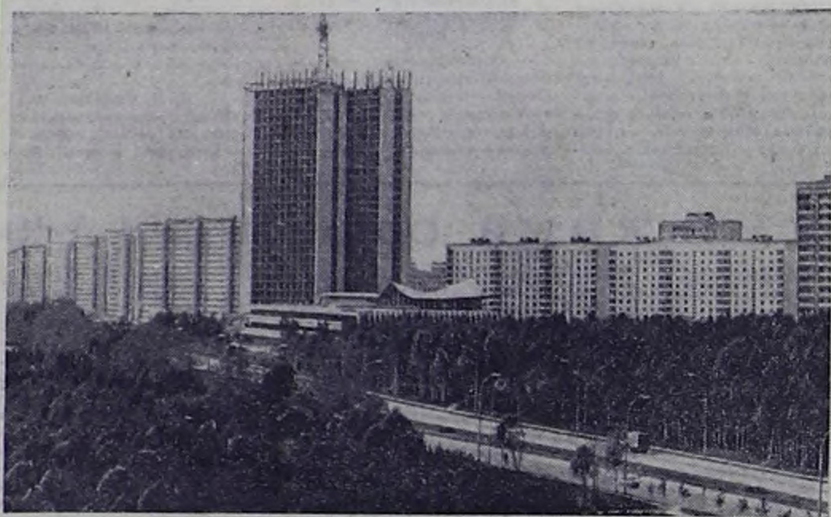
Москва. На Ленинском проспекте возводится Центральный Дом туриста ВЦСПС с гостиной на 1.300 мест и развитой системой обслуживания.
