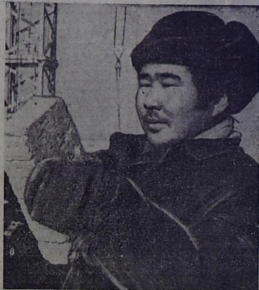
Иван Чанчыл — один из лучших наемников передовых мехколхозов № 18, строителей города Новый Шаганар. В составе бригады Алексея Конечина он возводит сейчас стены первого в городе крупного кирпичного здания — школы. Рационально используя каждую минуту рабочего времени, передовой наемник постоянно перевыполняет норму выработки.
