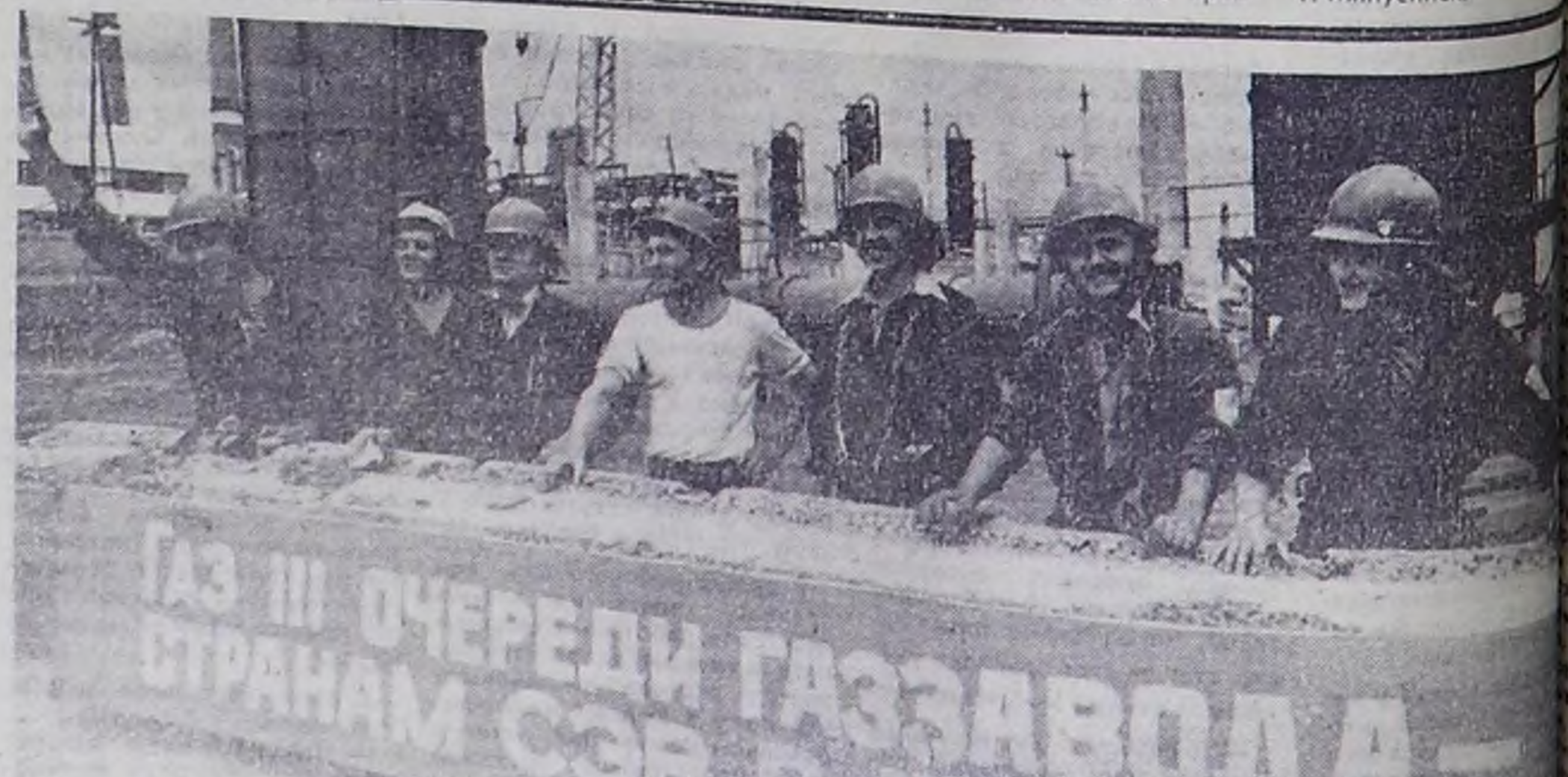
В цехе передовой бригады газопровода «Оренбурггазпром» — работники цеха. Фото В. Минусинский.
