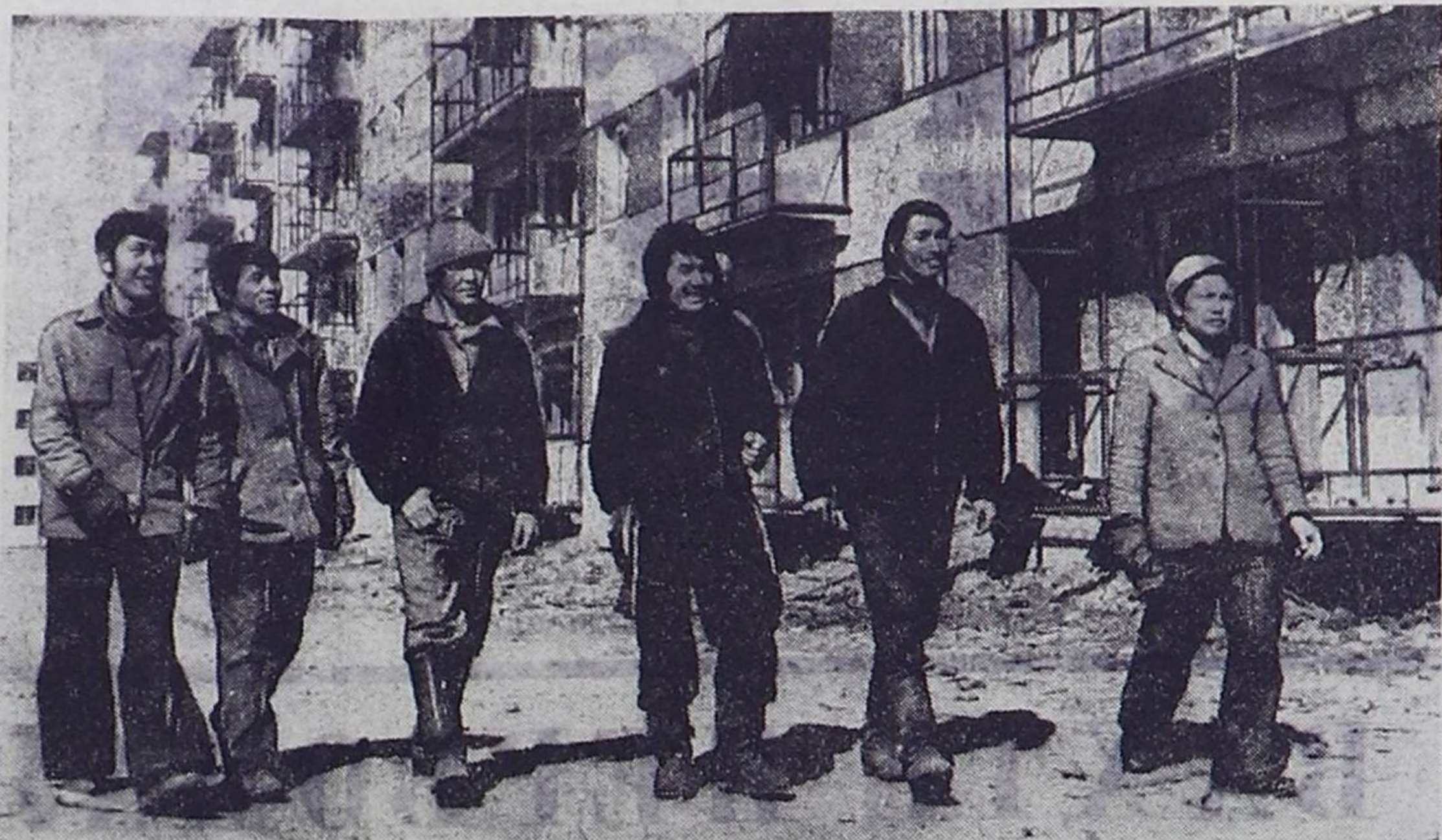
Высокопроизводительно трудятся на отделке крупнопанельных жилых домов в пятом микрорайоне столицы Тувы молодежная бригада плотников СУ-48, возглавляемая Ч. К. Иргитом. Ежемесячные задания плотники постоянно перевыполняют на 40-60 процентов.
