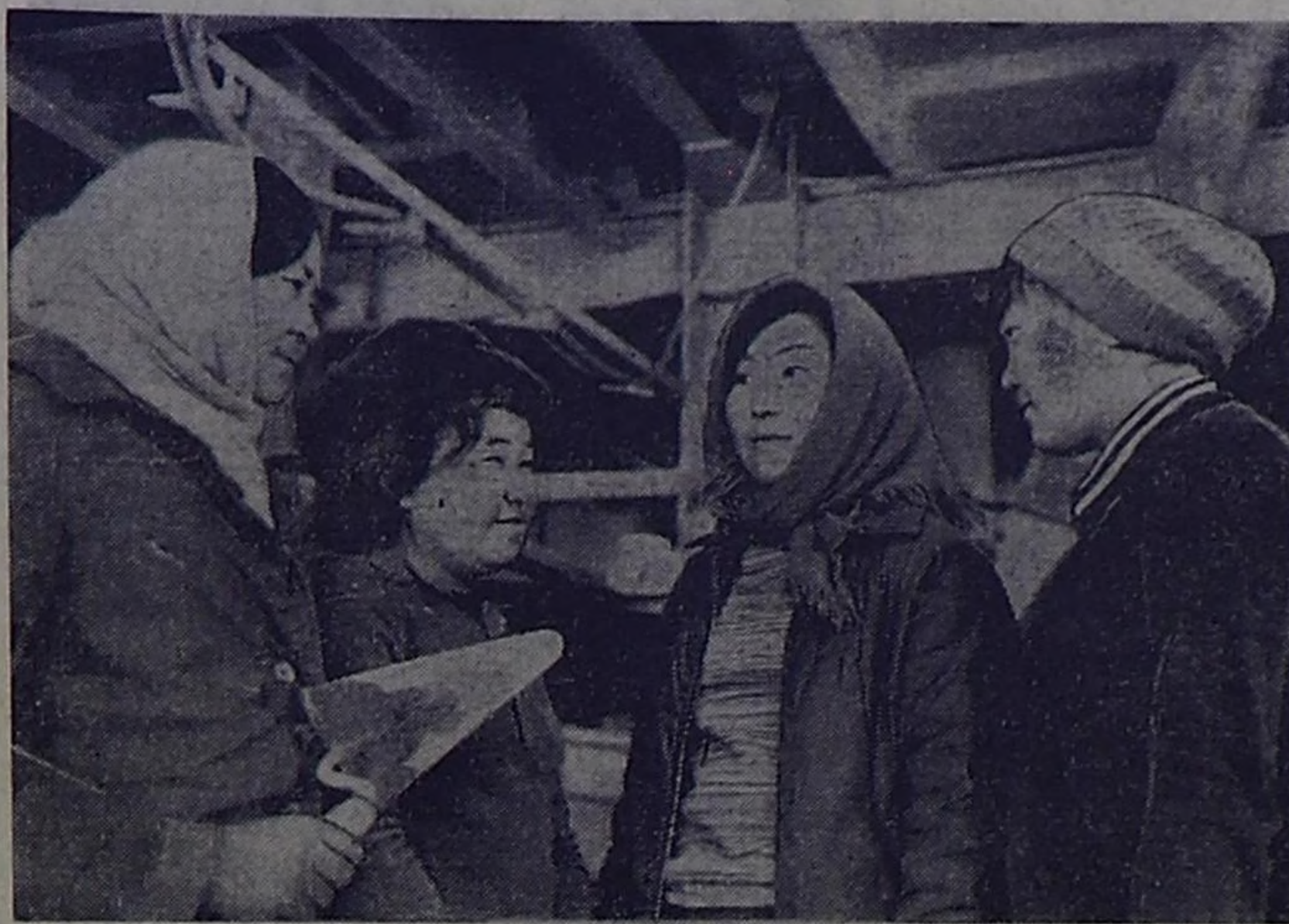
Ударно поработали на второй очереди комбината «Туваэсбел» комсомольцы строительного отряда республики. На снимке: (слева направо) лучшие отделочники отряда, которые постоянно выполняют задания в главном корпусе комбината, Марина Монгуш, Раиса Хомушку, Полина Ондар (бригадир) и Зоя Монгуш. Фото В. Кудрявцева.
