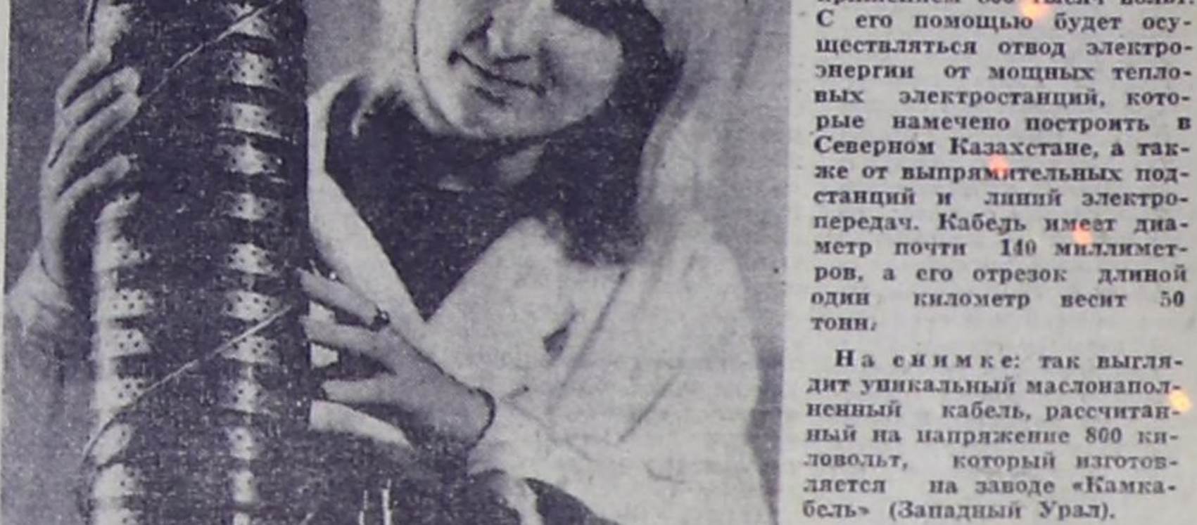
На заводе «Камкабель» (Западный Урал) впервые в советской электротехнической промышленности изготовлен высоковольтный кабель, рассчитанный на передачу постоянного тока напряжением 800 тысяч вольт. С его помощью будет осуществляться отвод электроэнергии от мощных тепловых электростанций, которые намечено построить в Северном Казахстане, а также от выпрямительных подстанций и линий электропередач. Кабель имеет диаметр почти 140 миллиметров, а его отрезок длиной один километр весит 50 тонн. На снимке: так выглядит уникальный высоковольтный кабель, рассчитанный на напряжение 800 киловолт, который изготавливается на заводе «Камкабель» (Западный Урал). Фото Э. Котлякова. (АПН).
