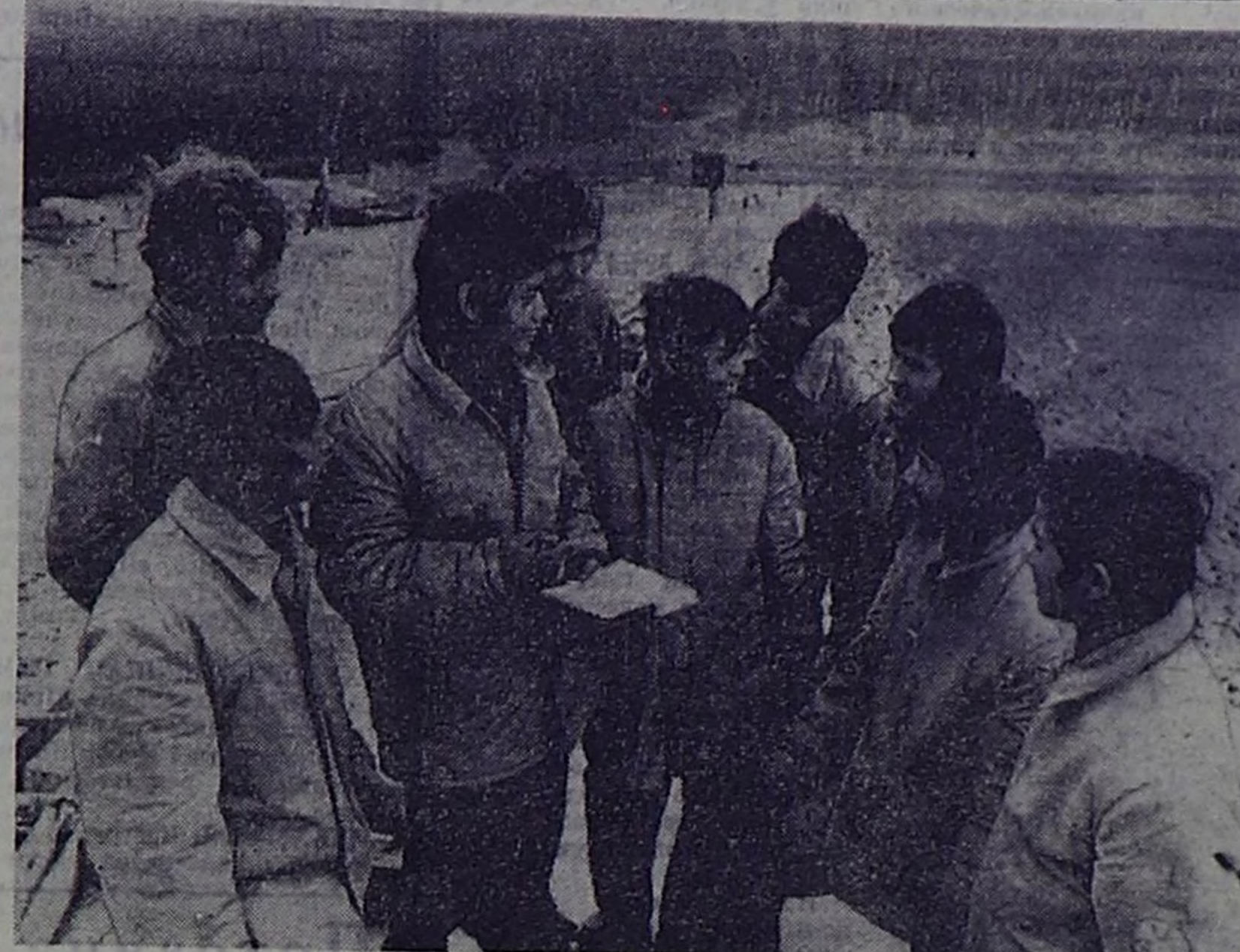
В строительстве плотин Присечнице в ЧССР принимали участие интернациональные бригады. Бок о бок с чехами и словаками трудились посланцы Социалистической
