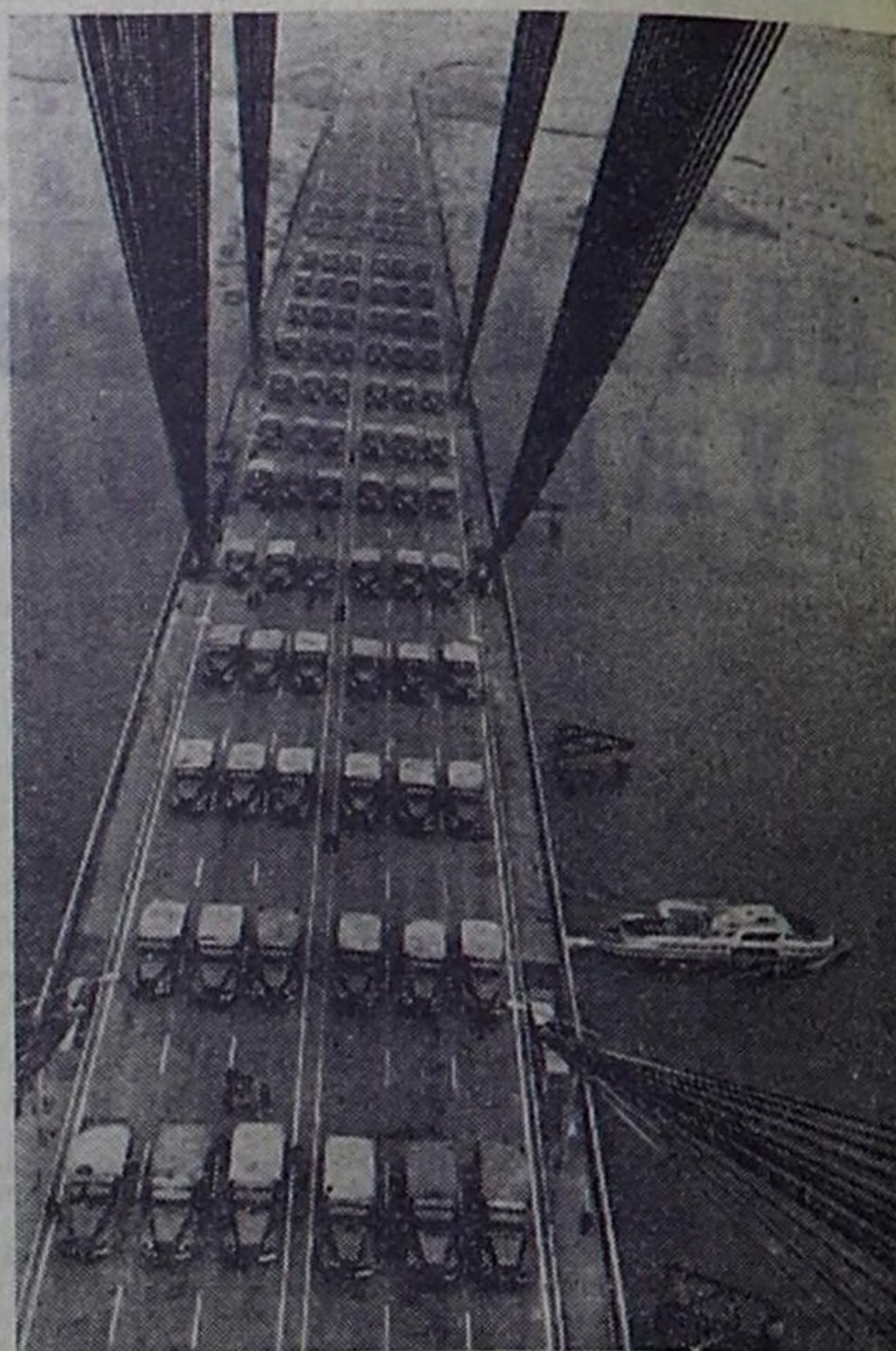
Украинская ССР. В Киеве построен крупнейший в Советском Союзе вантовый мост. Главный пролет гигантского сооружения протяженностью 300 метров как бы парит над Днепром. Ширина его проезжей части достигает 24 метров.
