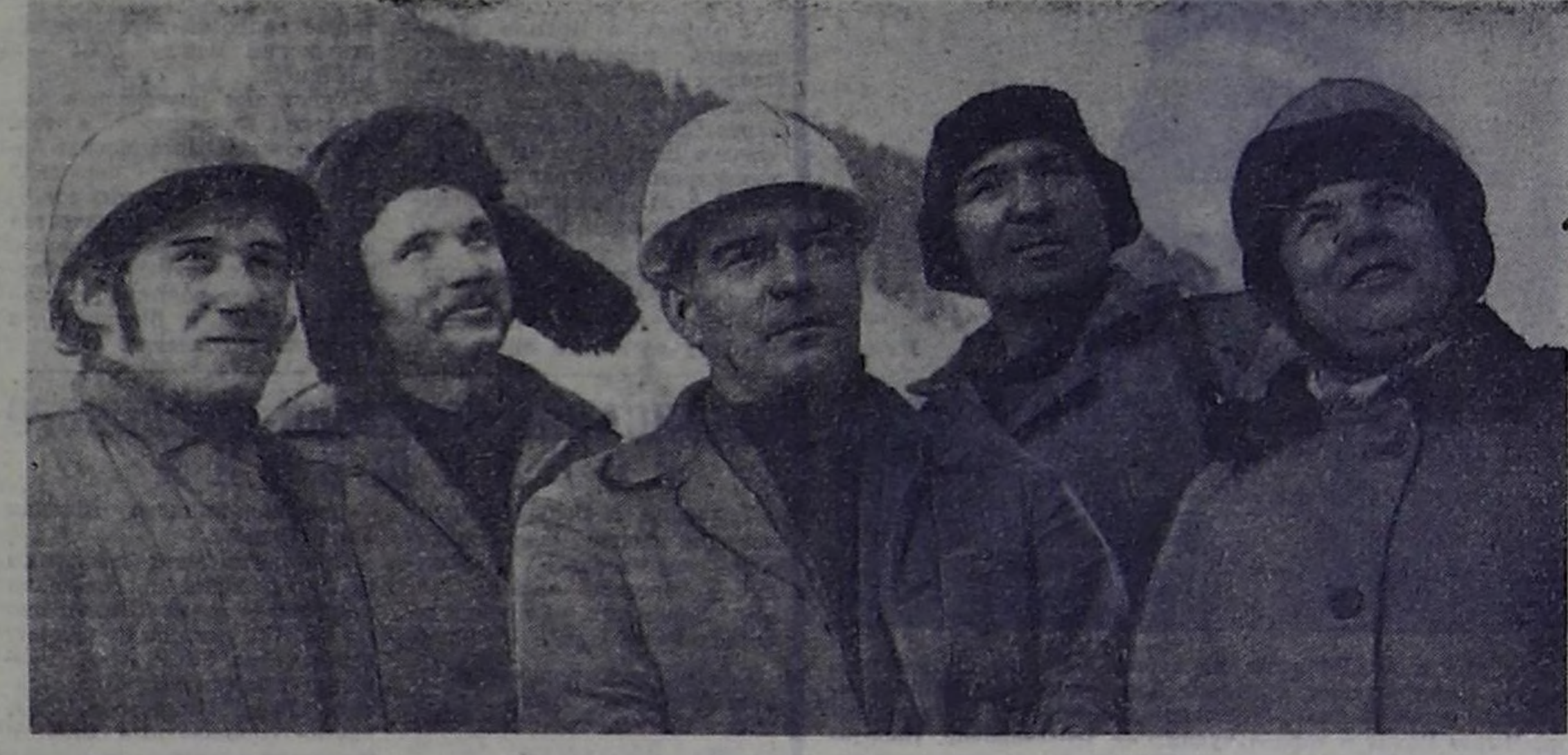
На строительстве Саяно-Шушенской ГЭС широко развернулось соревнование бригад, участков, экипажей экскаваторов, кранов, смосвалов за право укладки миллиона кубометра бетона в плотину гидроэлектростанции. Пятидесятая плотинно-бетонщицкая бригада плотинно-бетонщика Михаила Петровича Матченко из управления основных сооружений.
