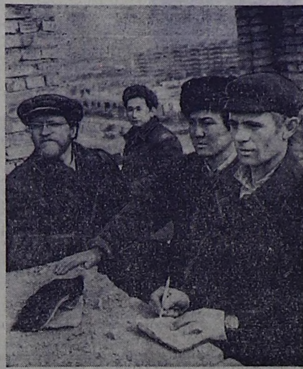
Комплексная бригада Вячеслава Ульянова из СУ «Кызылстрой» ведет кладку стен пятого этажа 110-квартирного жилого дома в четвертом микрорайоне столицы республики. Нынче новоселы должны получить здесь ключи от благоустроенных квартир, и строители прилагают все усилия, чтобы сдать дом под отделку к 100-й годовщине со дня рождения В. И. Ленина, а в августе предъявить его государственной комиссии.
