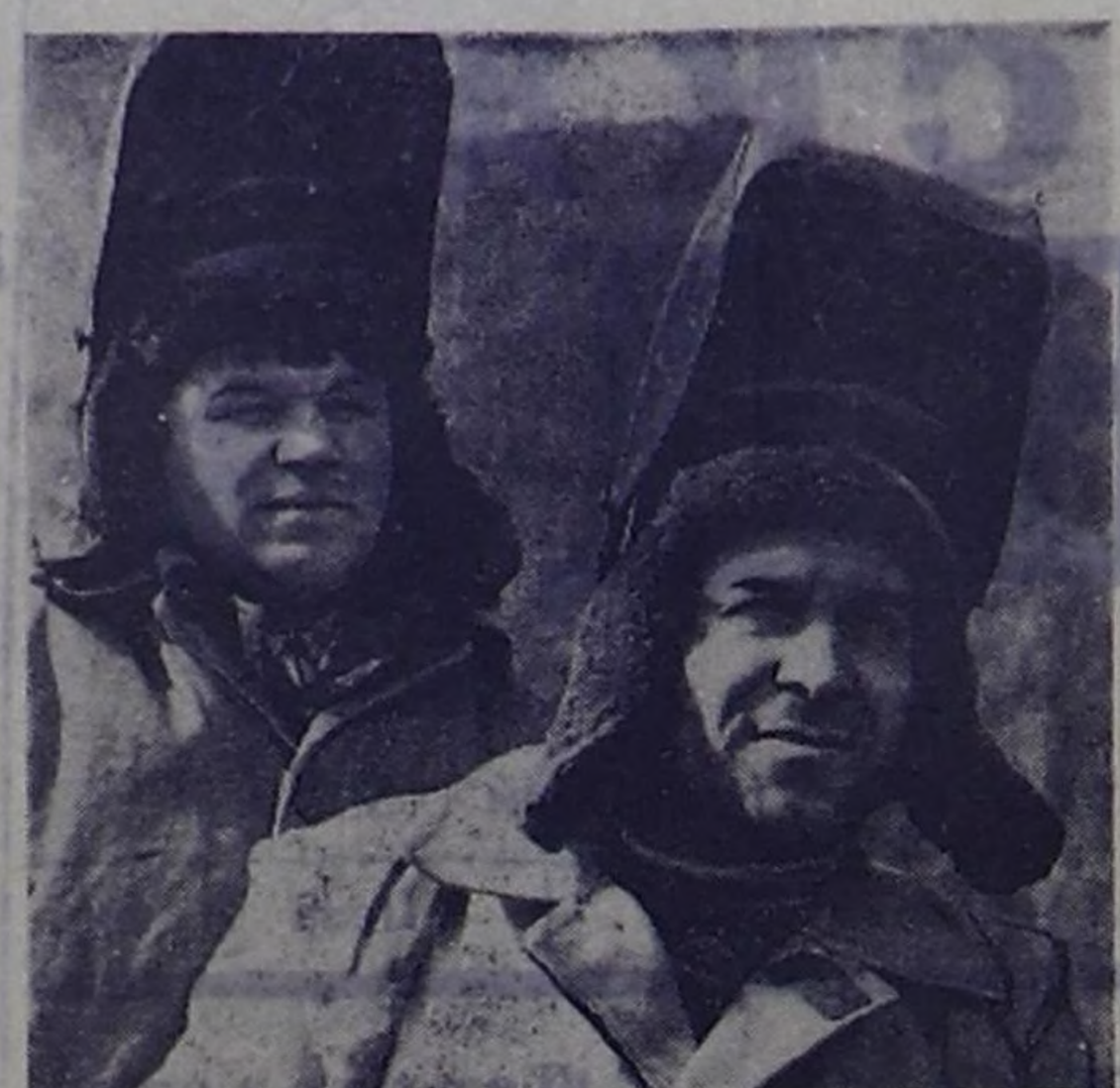
Строители крупнейшей на планете Саяно-Шушенской ГЭС готовятся к знаменательному событию — перекрытию Енисея. В октябре, при наиболее низком уровне воды в реке, гидроэлектростроители укроют сибирского богатыря. А сейчас в правобережном котловане будущего гидроузла полным ходом идет бетонирование основания водосливной части плотины. Десятки бригад соревнуются за право поднять в день перекрытия Енисея вымпел «Слава труду». В их числе и одна из лучших бригад «Гидромонтажа», возглавляемая Алексеем Алексеевичем Кудрявцевым. Этот коллектив гото-
