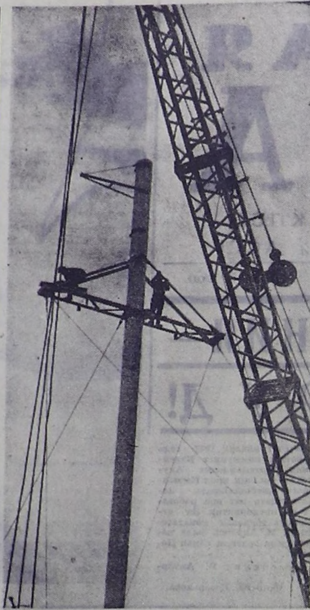
Одна за другой в степи выстраиваются опоры линии электропередачи Чадай-Сут-Холь. Пройдет январь, и бригада электромонтажников, которую возглавляет Александр Михайлович Тут, даст в эксплуатацию еще один участок ЛЭП мощностью в 110 киловольт. На верхнем снимке: монтаж опоры. Фото Ю. Косарькова.
