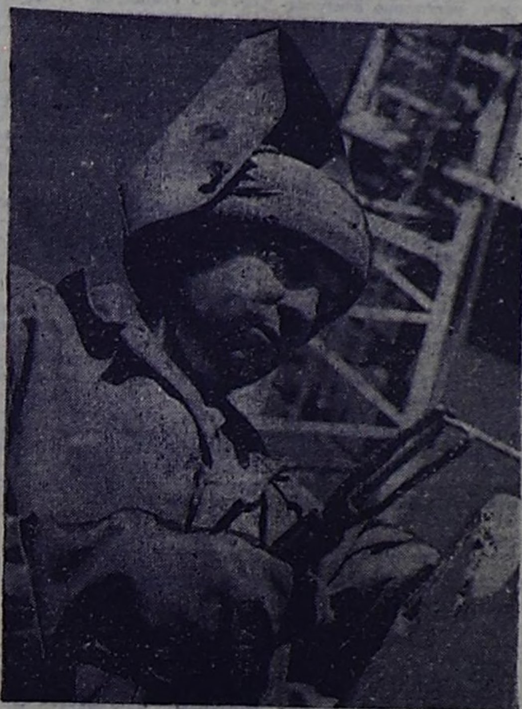
Однимнадцатый лет работает электросварщиком на комбинате новостройки коммунист Василий Васильевич Наволокин. Сейчас он в составе одной из лучших бригад управления «Кымысстрой», руководимой Алексеем Ивановичем Володимиром, ведет монтаж панельных домов в четвертом микрорайоне города. За высокие показатели в труде Василий Наволокин награжден Всесоюзным знаком «Победитель социалистического соревнования 1974 года». Ему присвоено звание ударника коммунистического труда.
