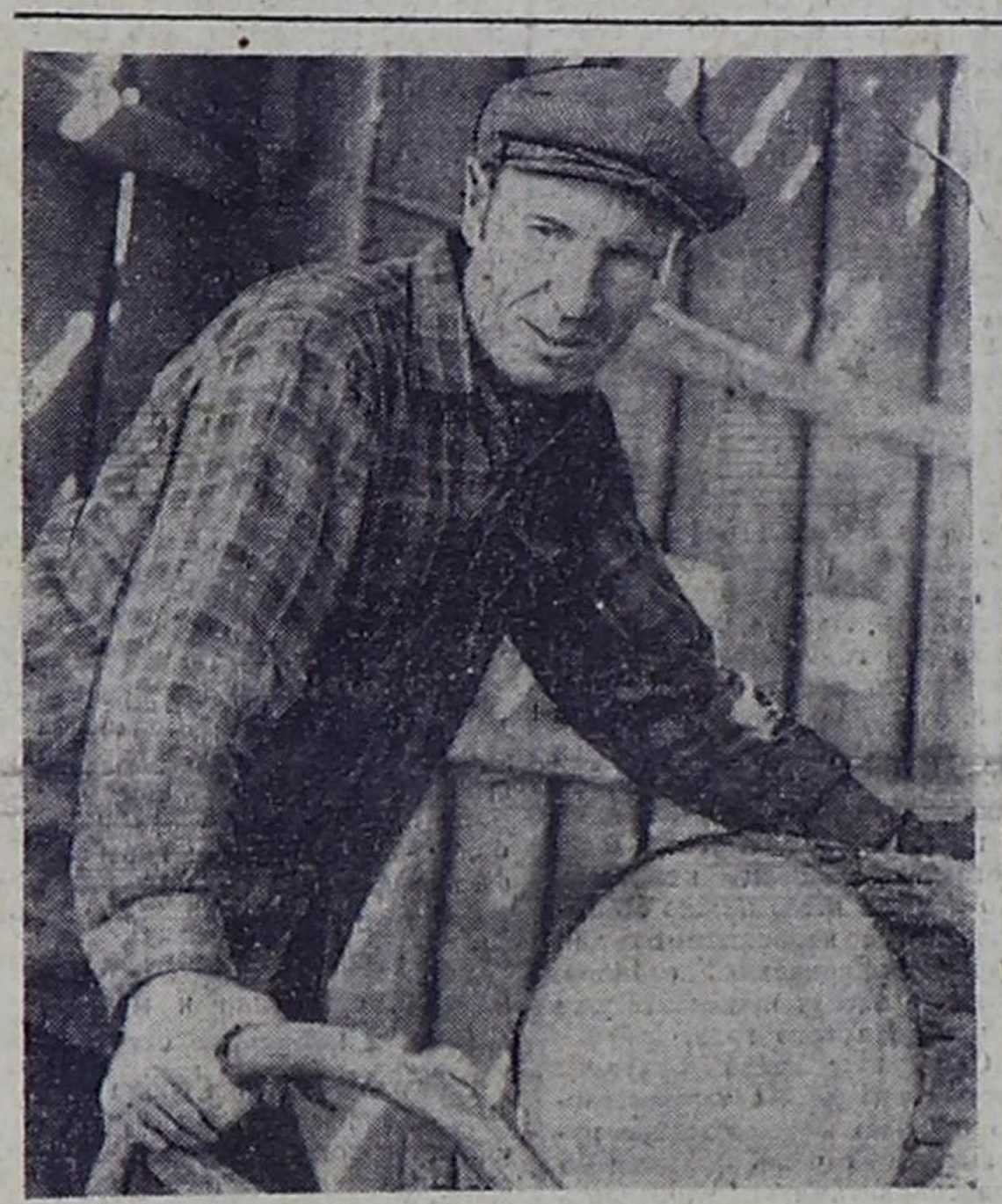
Бригада пиломатериалов лесопильного цеха комбината «Труда» (Тувинский), руководитель которой коммунист И. Х. Сам-оол, соревнуется за звание коллектива пиломатериалового цеха. Основное задание — производство пиломатериала для строек республики — рабочие постоянно выполняют на 110—120 процентов. Тон в трудовом соперничестве задает старший рабочий предприятия Иван Михайлович Лыткин (на снимке). Его портрет — на цеховой доске почета.
