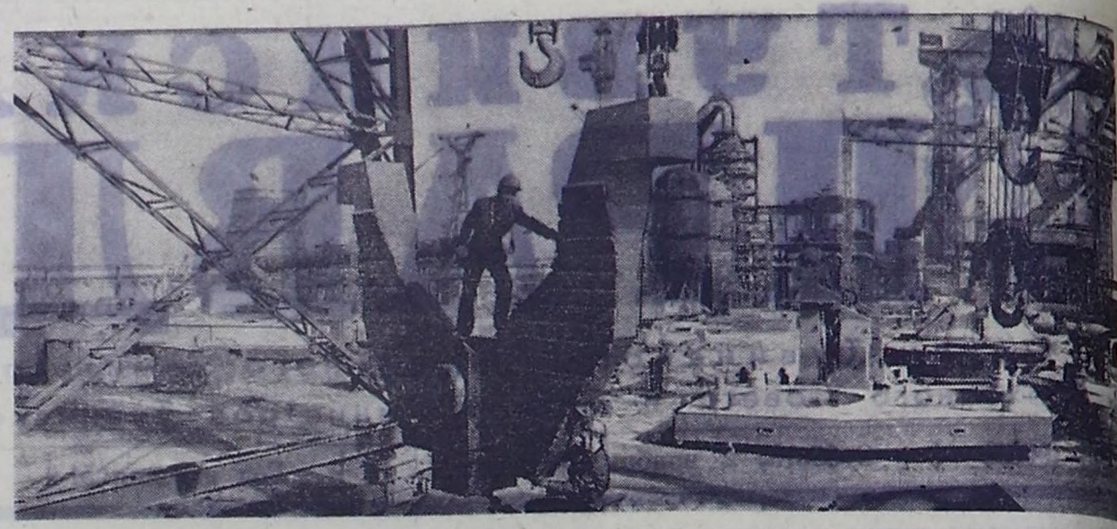
Днепротрестовская об- ласть. На строительстве крупнейшей в мире доменной печи № 9 Криворожского металлургического завода наступил предпоследний период. Смонтированы сотни тонн металлоконструкций, подведены сотни километров труб. На площадке непрерывно поступает сложное современное оборудование. Многомесячный коллектив строителей стремится закончить сооружение домины к концу нынешнего года.
