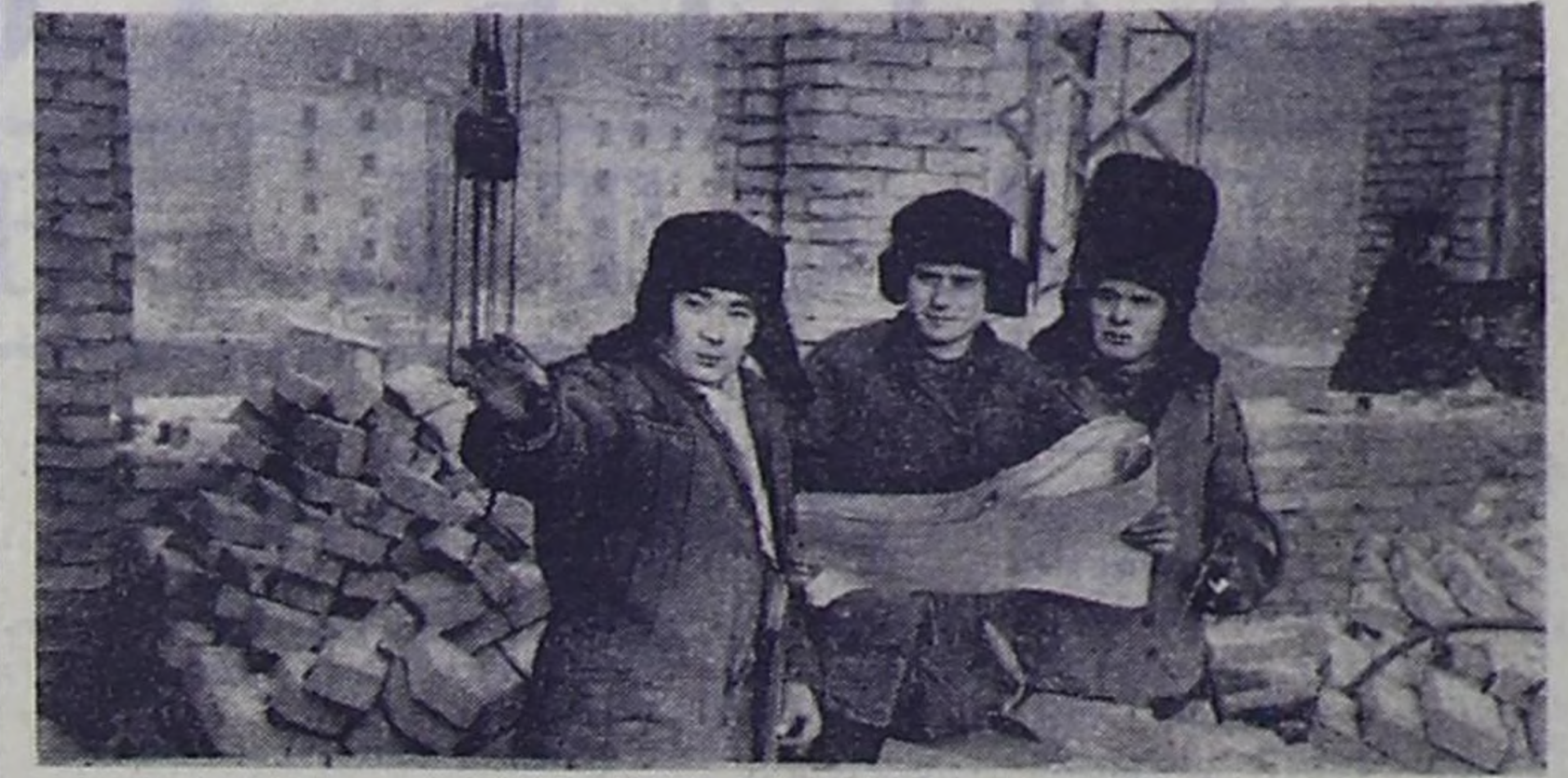
Ударно работает на строительстве гостиницы «Турист» коллектив передовой бригады СУ «Кизилстрой» Н. К. Везиго-ского. В соревновании лидируют А. В. Покоянов, Н. П. Мишуткин и М. П. Карпов (на снимке слева направо).
