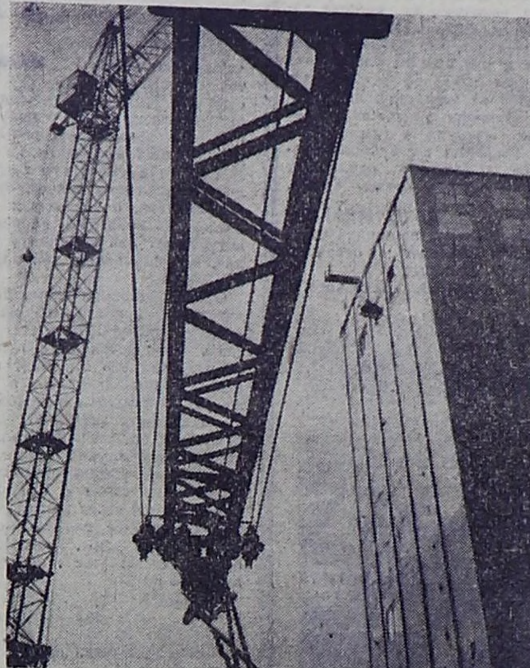
На сорок метров поднялся корпус комбинированного цеха.
