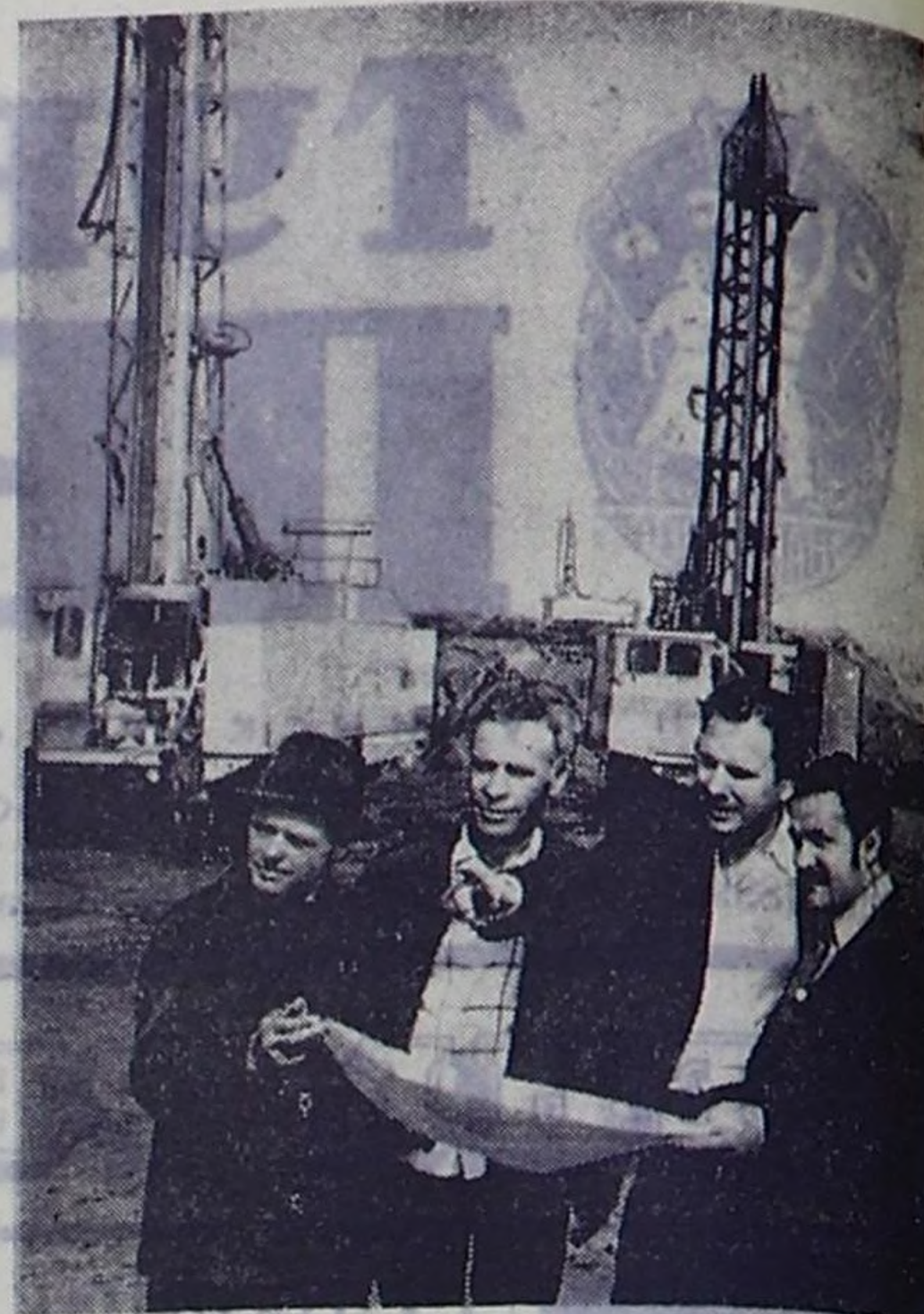
Вскрытые работы и добыча угля на Кая-Хемском разрезе...
