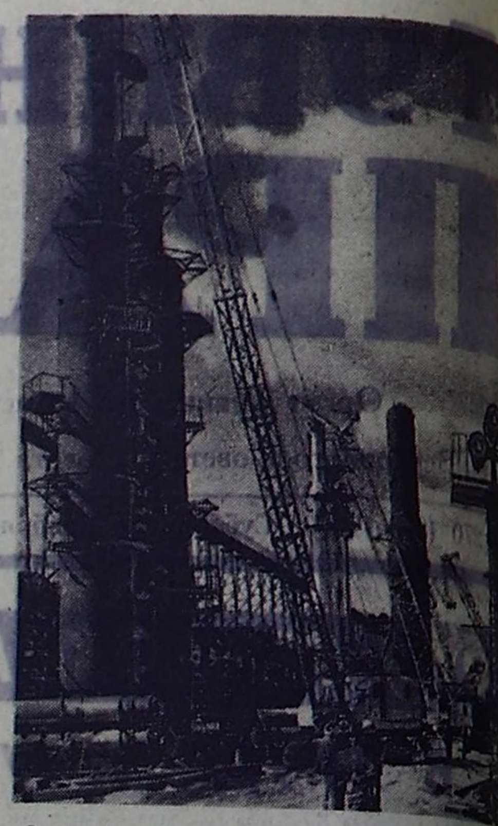
Строящийся в Белоруссии Мозырский нефтеперерабатывающий завод.
