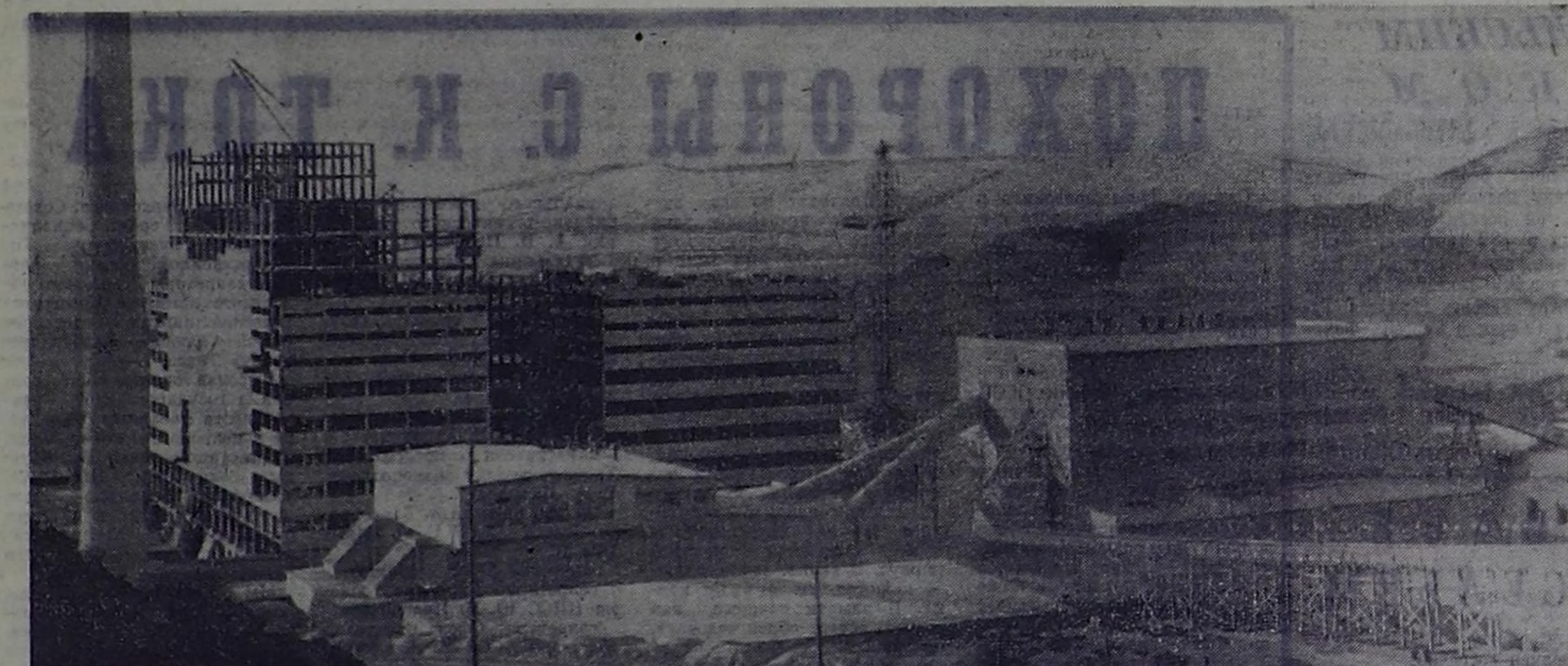
Главная новостройка республики. Растут корпуса второй очереди горно-обогатительного комбината «Туваобтест».
