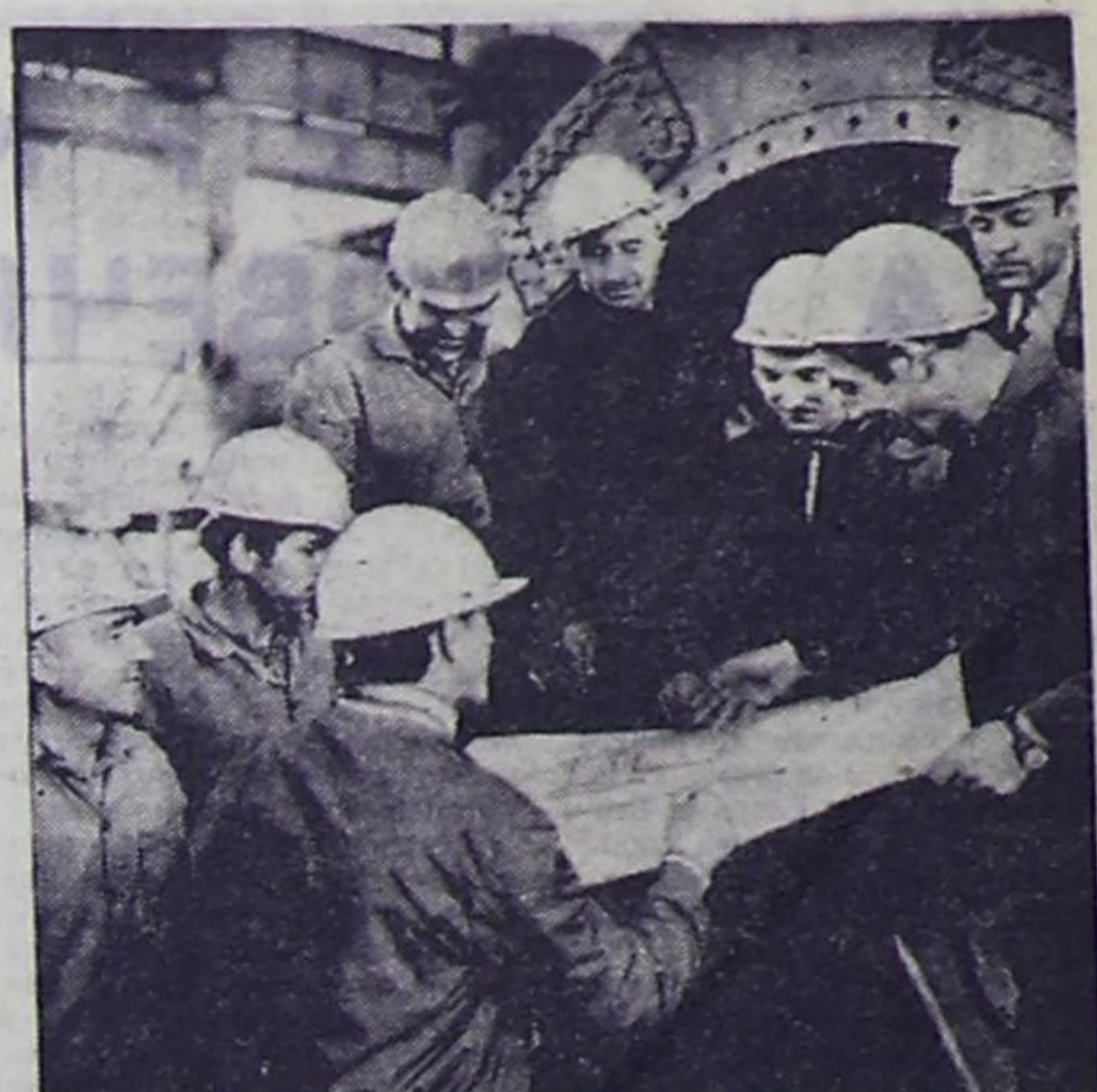
БОЛГАРИЯ. Вот уже три года на дунайском берегу у города Козлодуй рвет знамя национальной молодежной стройки. Здесь в четком ритме трудовых будней рождается завтрашний день болгарской энергетики — первая атомная электростанция. Возводятся АЭС «Козлодуй» при непосредственном участии советских специалистов. Им разработаны проекты основных корпусов, они оказывают помощь в монтаже станции. Большая часть оборудования поставлена также из СССР.
