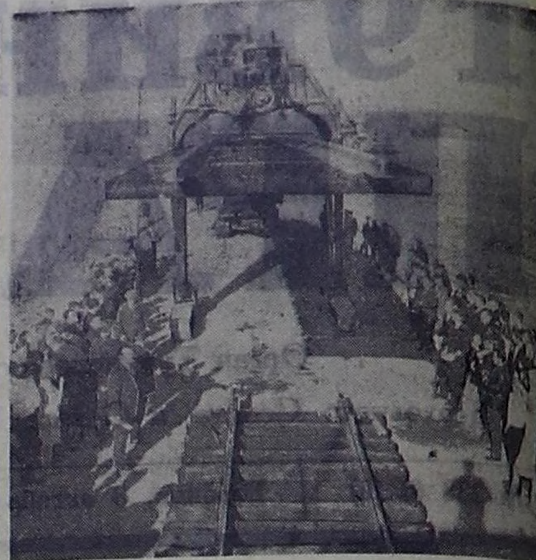
Амурская область. Начало строительства железной дороги Бам—Тында. Она свяжет Транссибирскую магистраль с таежными и горными районами северного Приамурья, богатыми полезными ископаемыми и лесом. Строители решили в 50-летие образования СССР уложить первые 20 километров пути. На снимке: укладываются первые звенья пути новой железной дороги. Фото Г. Калачёва. (Фотохроника ТАСС).
