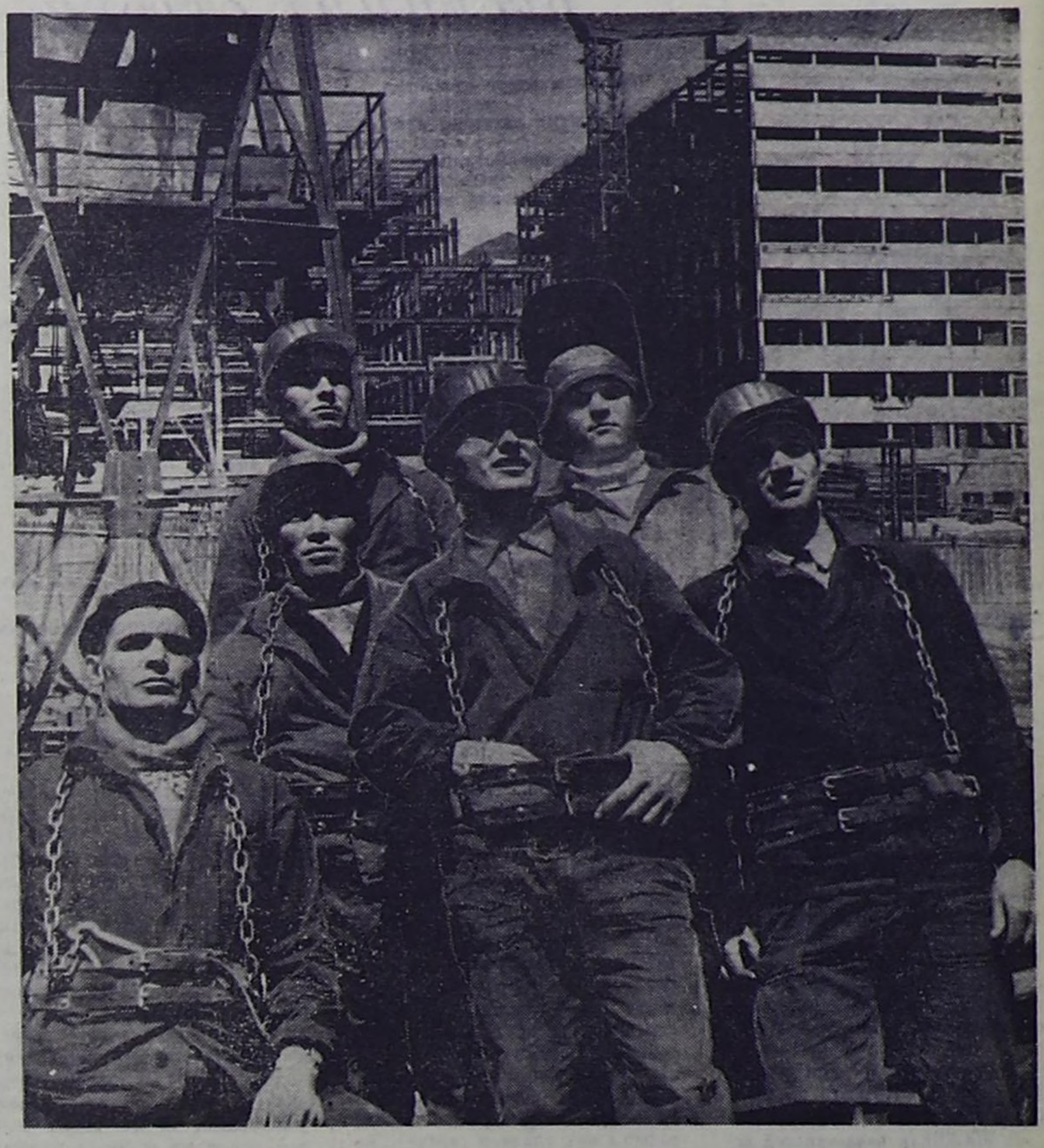
На 39-метровую высоту поднялся уже металлургический карьер главного корпуса второй очереди комбината «Тувакобальт». Здесь координируют монтажники А.К. Довурского участка треста «Сибстальконструкция». На снимке: переводные монтажники участка бригадир Николай Коналов, Клим Ооржал, Анатолий Хитрук, Владимир Ларин, Валерий Курасов и электросварщик Александр Шкабаров. Фото А. Остапчука.
