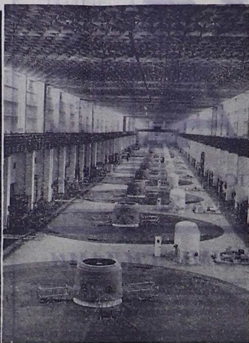
В скором времени гидростанция у Дивных гор на Енисее достигнет мощности в шесть миллионов киловатт. Приблизительно пуск 12-го агрегата, который уже поставлен на холостые обороты.
