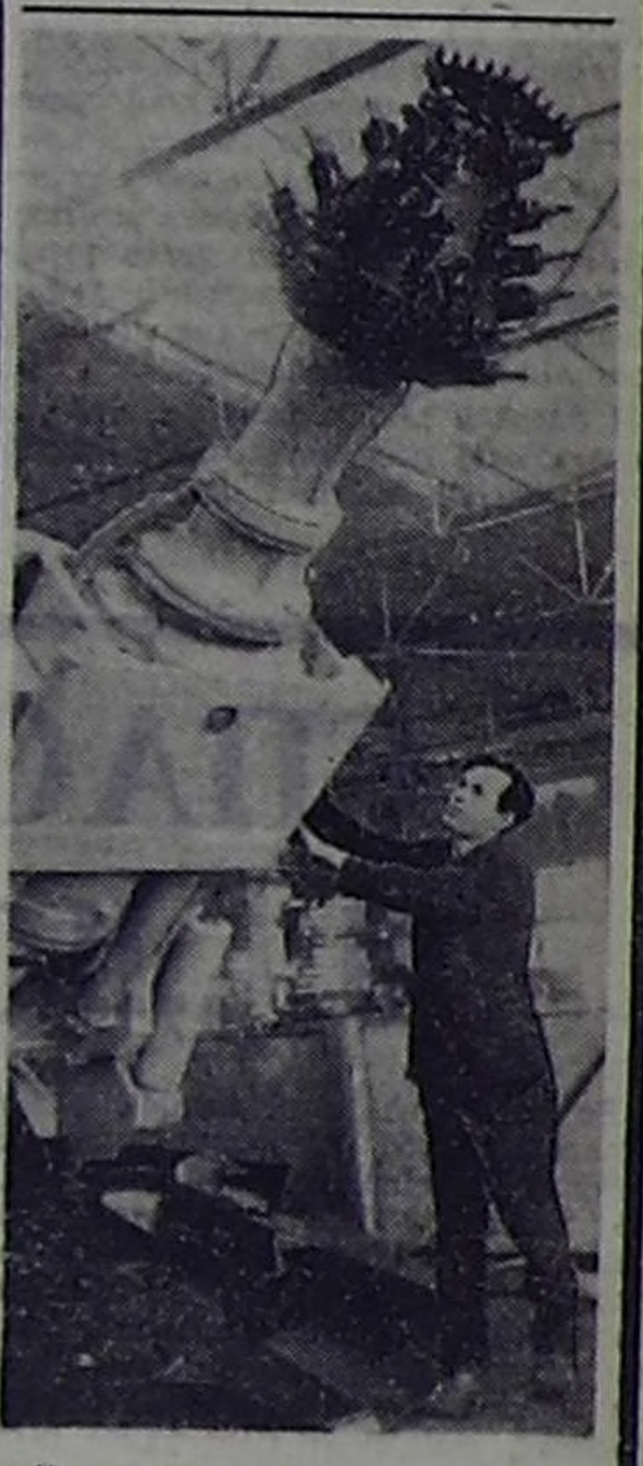
Челябинская область. Многие шахты нашей страны оснащены горными машинами Копейского завода имени С. М. Кирова. Прогрессивный комбайн «4ПУ» широко применяется на шахтах не только у нас, но и в Чехословакии, Румынии, на Кубе. На снимке: оверлоидный комбайн «4ПУ» на испытании в цехе перед отгрузкой. (Фотохроника ТАСС).
