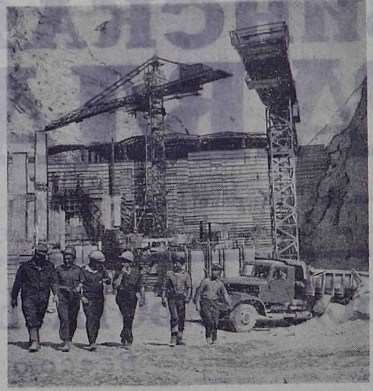
Киргизская ССР. На берегах стремительного Нарына, где возводится крупнейшая в Средней Азии Токтогульская ГЭС, горячие дни. Гигантская арочная плотина воздвигнута, в котором будет собрано 19 миллиардов кубометров живописной влаги для орошения засушливых земель Киргизии и Узбекистана, растет на глазах. Сейчас бетонщики работают на отметке 87 метров — это почти треть всей высоты будущего сооружения. Ежедневно коллектив укладывает в тело плотины 2400 кубометров бетона.
