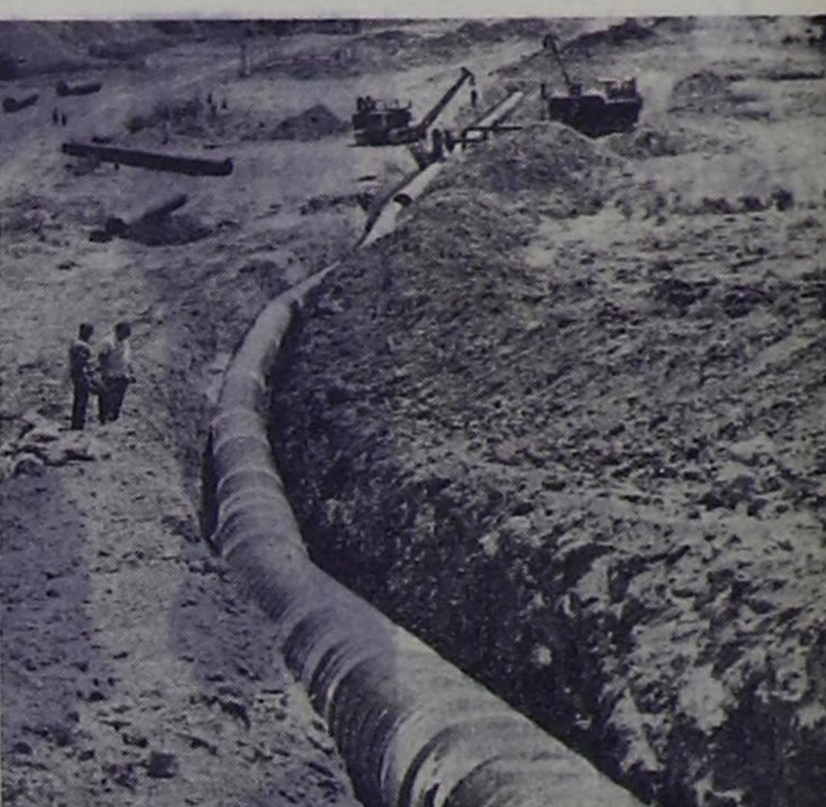
Азербайджанская ССР. Коллектив СУ-5 Ростовского объединения «Огазпромстрой» приступил к прокладке труб на последнем этапе второй 85-километровой нитки газопровода Иран—СССР. Строителям предстоит пройти в азербайджанских субтропиках 10 километров тяжелого горного участка с подземными переходами через реки, овраги, водоохранные. Новая линия позволит ежегодно принимать дополнительно 8 миллионов кубометров иранского газа для республик Закавказья.
