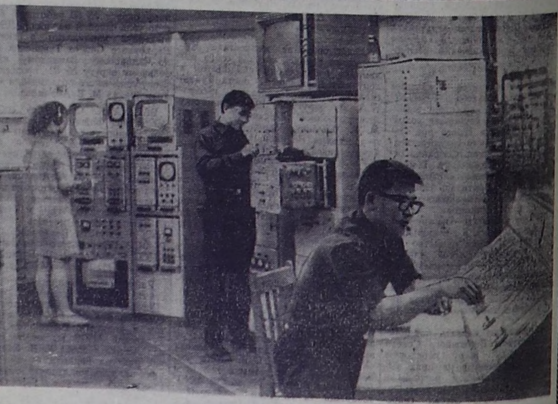
Спутник «Молия». Не все телезрители республики знают, что передачи Центрального телевидения принимает наземная станция «Орбита» с этого спутника. Коллектив здесь молодой. Сложные приборы, установки, оборудование всегда содержат в полном порядке инженеры Владимир Донгакович Байр-оол (на первом плане), Эрс-оол Александрович Монгуш и Людмила Ивановна Байр-оол.
