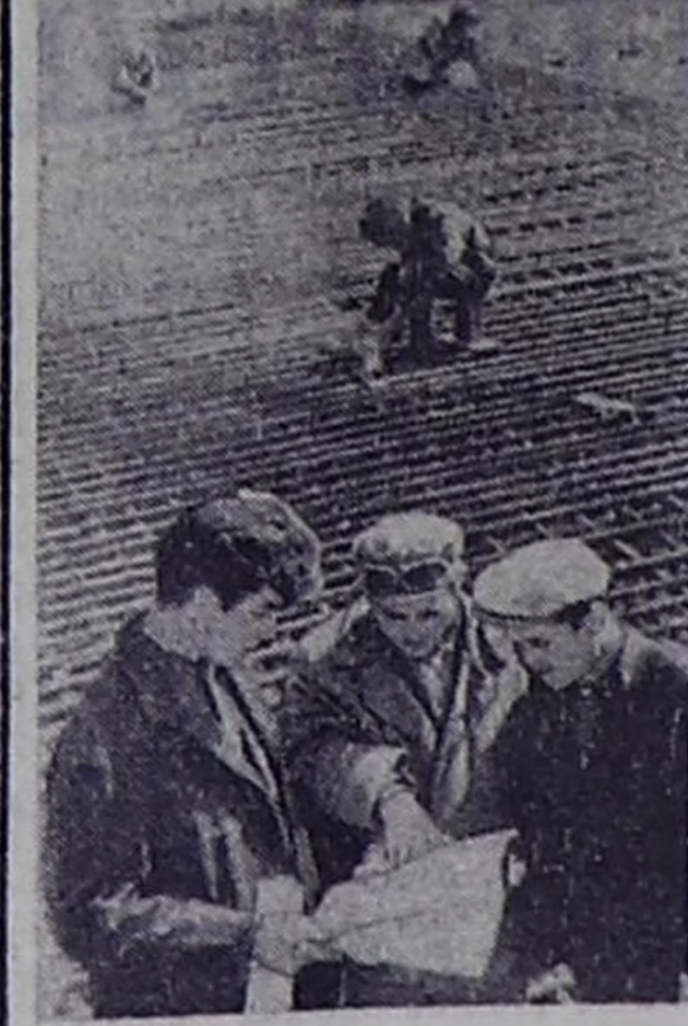
На Новополюском металлургическом заводе начато сооружение новой, пятой по счету, доменной-гиганта. Объем печи составит 3,200 кубометров. Коллектив треста «Липецкстрой» обязался ввести домну в строй действующих во втором квартале 1972 года.
