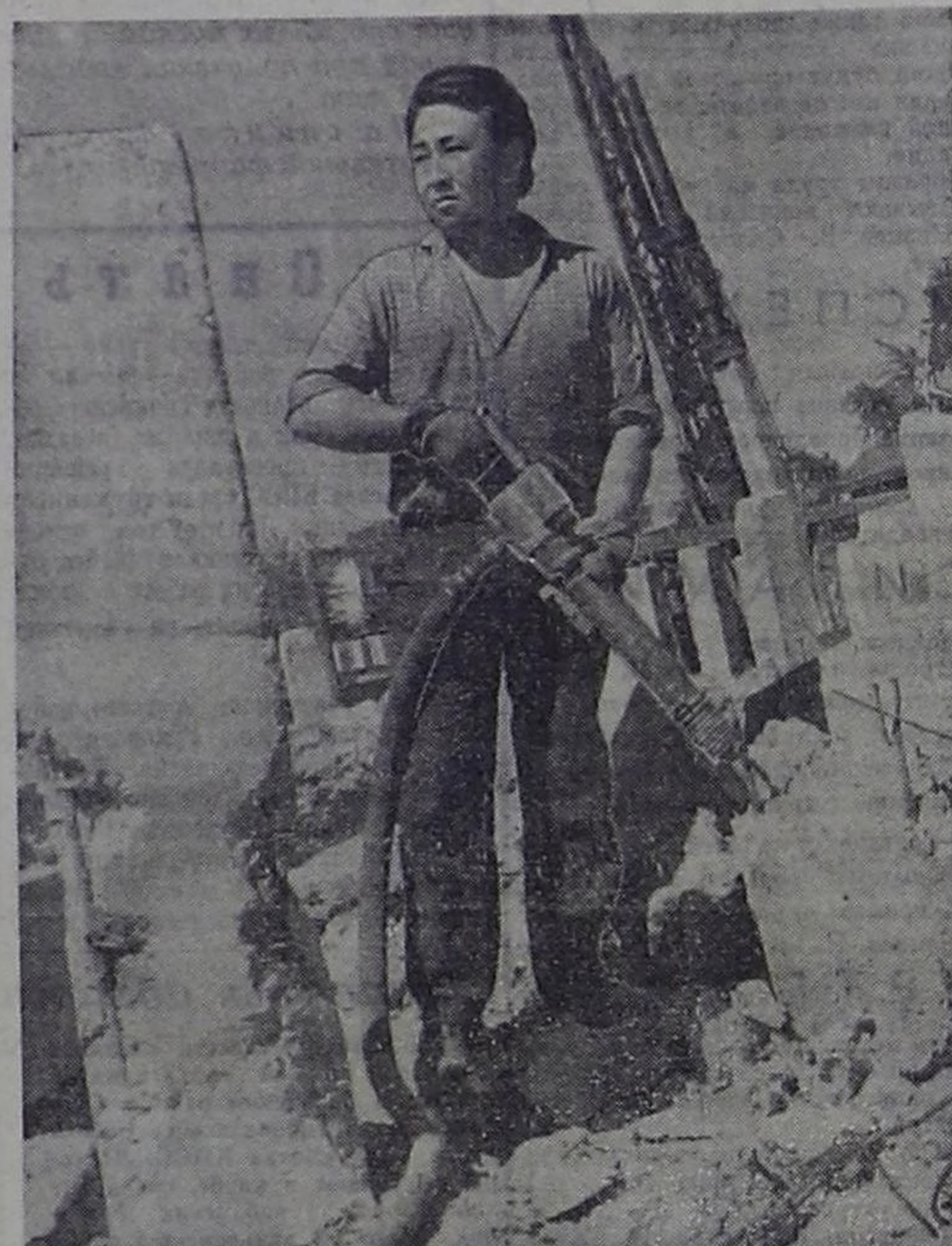
На строительной площадке будущего театра трещат «выстрелы» отбойного молотка. Здесь работает коммунист Демир Ангырбан из СУ «Кызылстрой». В свободное время Демир — участник городского ансамбля песни и танца.
