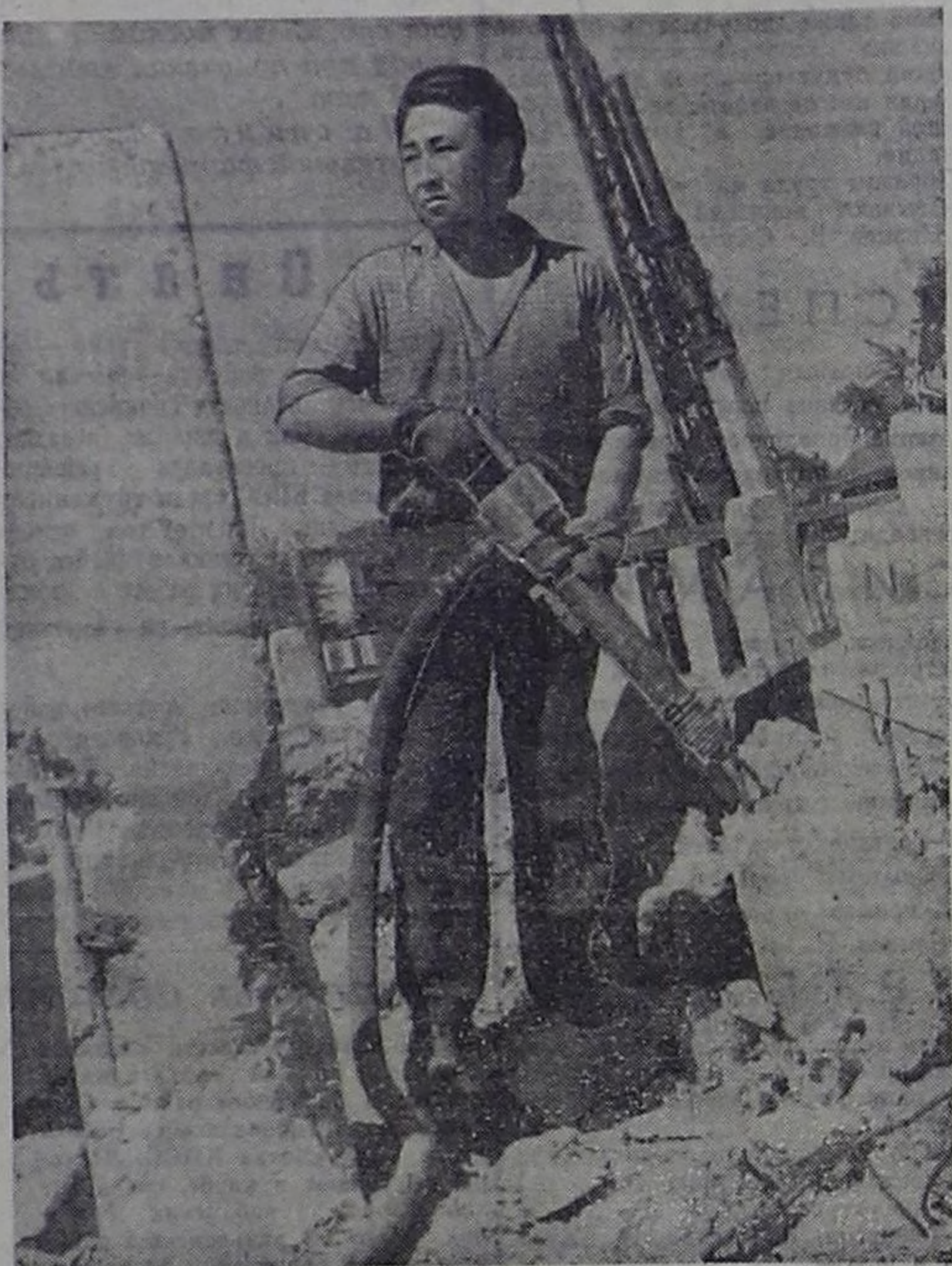
На строительной площадке будущего театра трещат «выстрелы» отбойного молотка. Здесь работает коммунист Демир Ангырбан из СУ «Кызылстрой». В свободное время Демир — участник городского ансамбля песни и танца.
