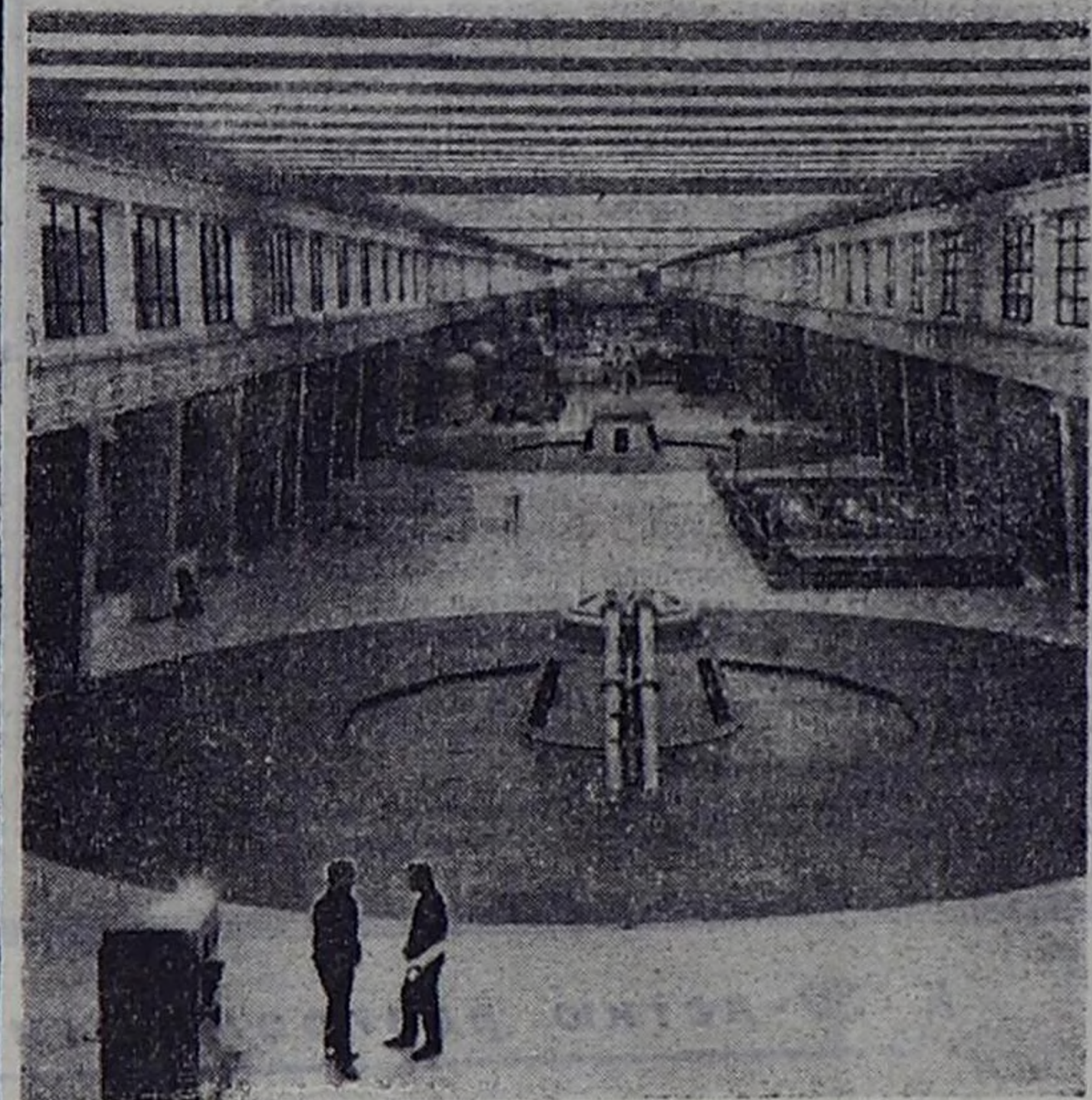
Балаково (Саратовская область). Государственная комиссия подписала акт о приеме в промышленную эксплуатацию Саратовской гидроэлектростанции имени Ленинского комсомола. Со времени пуска первой турбины ГЭС вырабатала более 17 миллиардов киловатт-часов электроэнергии. На снимке: в машинном зале Саратовской ГЭС. Фото Ю. Набатова. (Фотохроника ТАСС).
