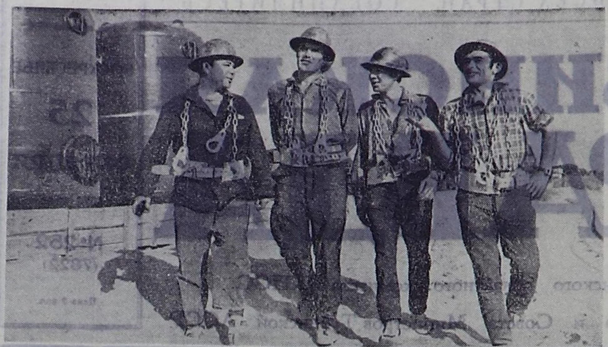
Туркменская ССР. Недалеко от города Мары на берегу Каракумского канала раскинулась огромная строительная площадка. Здесь сооружается крупнейшая в Туркмени электростанция.
