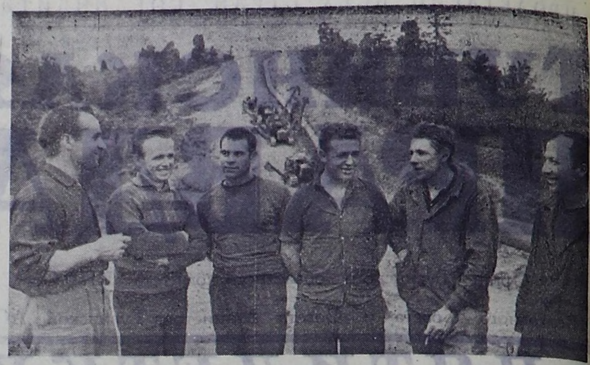
Успешно завершилось строительство Трансиранского магистрального газопровода — одной из важнейших советско-иранских строек.
