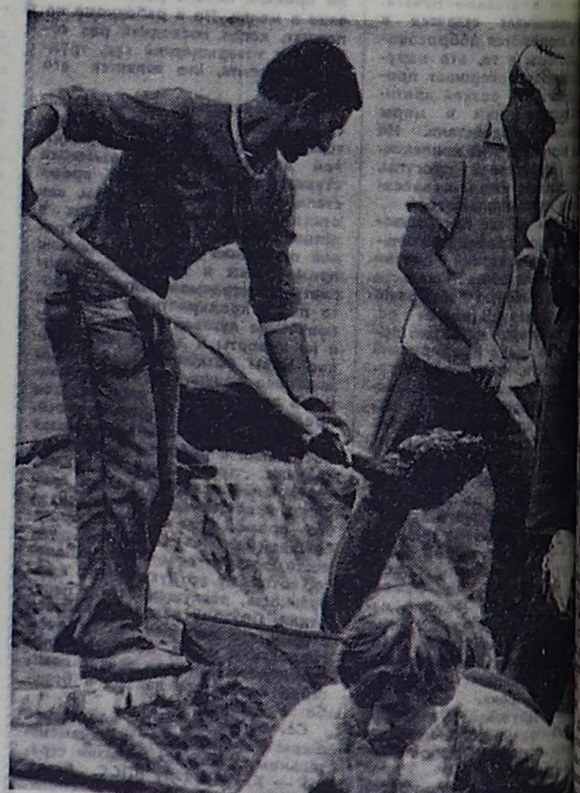
Бетон укладывает бригада Володи Федосова.
