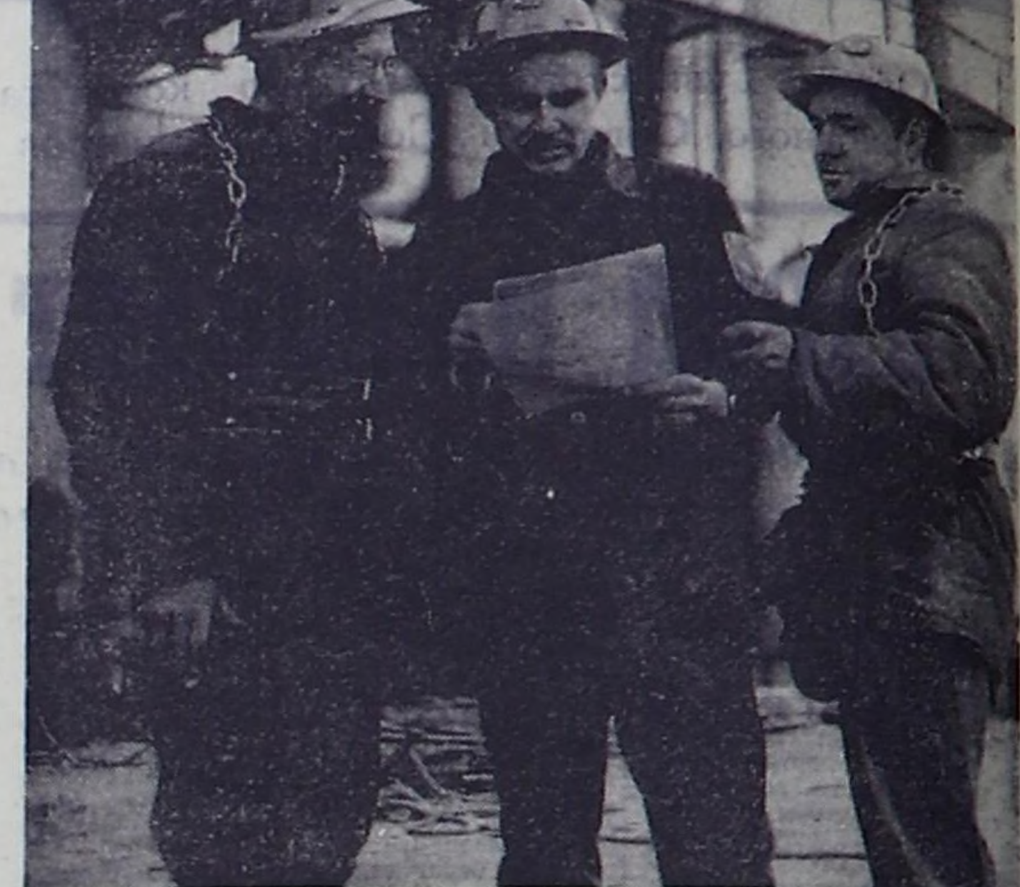
Основное технологическое оборудование прошло через руки монтажников участка «Сибтехмонтажа». На снимке (слева направо): бригадир Иван Жолоб, прораб участка Владимир Шапкин, звеньевой Владимир Зубарев. Фото А. Остапчука.
