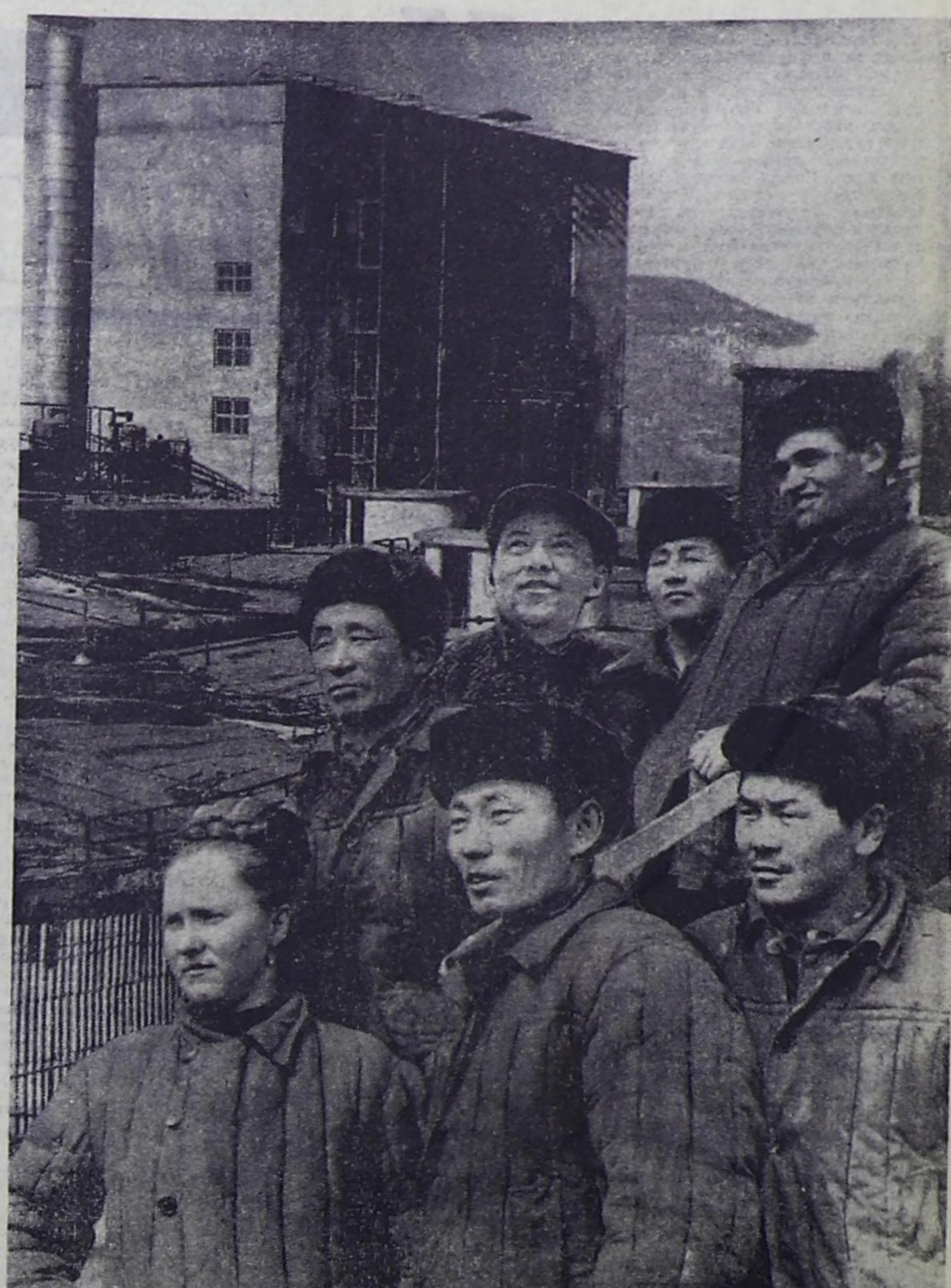
Группа передовых рабочих, ветеранов строительства комбината «Тувакобальт»: первый ряд (слева направо) — бетонщик Валентина Паршакова, бригадир плотников-бетонщиков Хунай-оол Натан-оол, плотник-бетонщик Баджик Мерген; второй ряд — бригадир плотников-бетонщиков Иргит Монге, прораб Михаил Чертыгашев, плотник-бетонщик Иван Ланзы, бригадир колесной бригады Анатолий Глухов.
