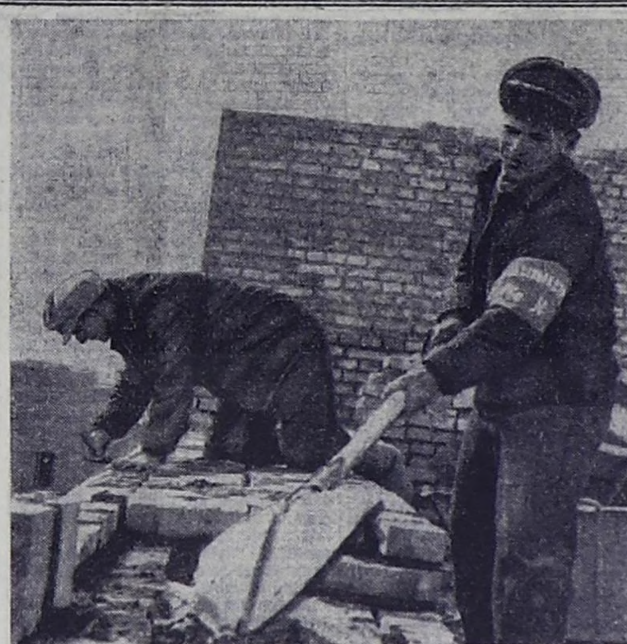
Ряд за рядом укладывает кирпич звено каменщиков Владимира Сидорова (на первом плане) из СУ «Кызылстрой».
