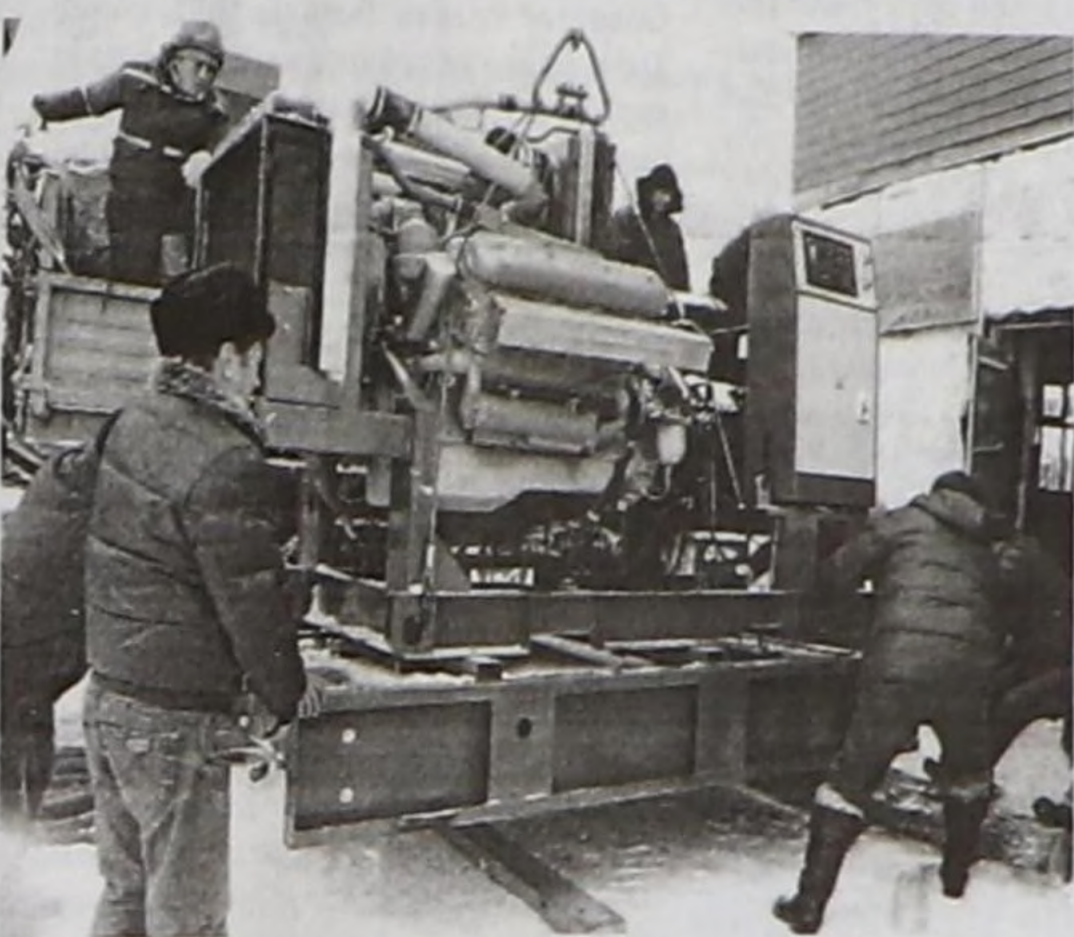
Дизельдиг электростанцияны тургузуп турары.
