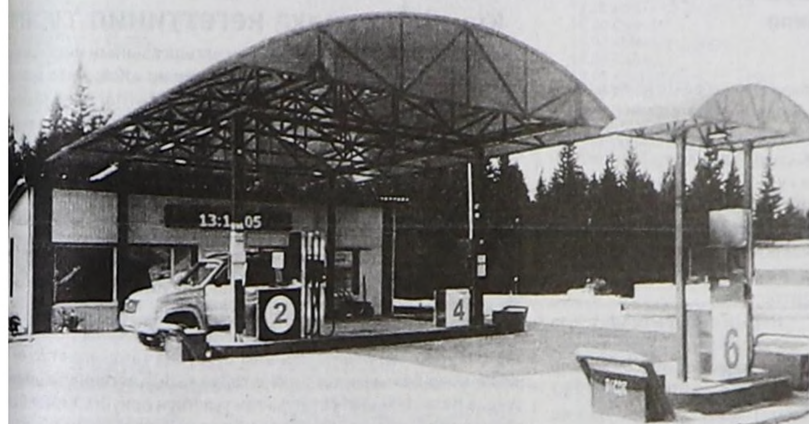
Сарыг-Септе кывар-чаар чүүлдер станциясы (АЗС).
